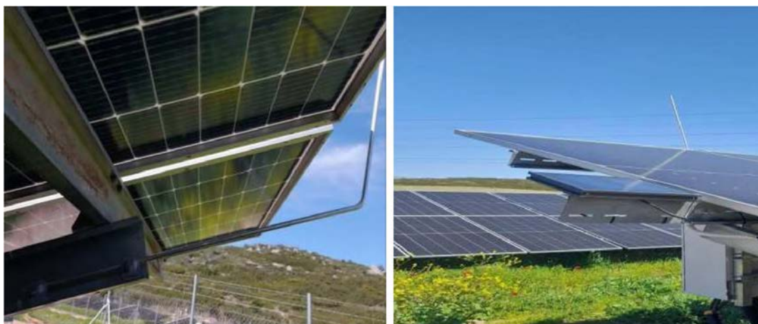
Εικόνα 2.16: Τοποθέτηση μεταλλικής ράβδου του συλλεκτήριου συστήματος.
