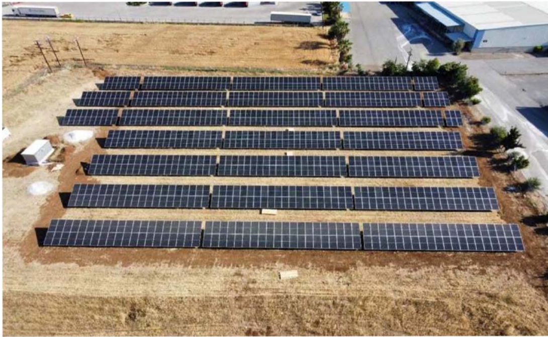
Εικόνα 2.14: Φωτοβολταϊκό πάρκο με οριζόντια διάταξη (landscape) στην Εύβοια.
