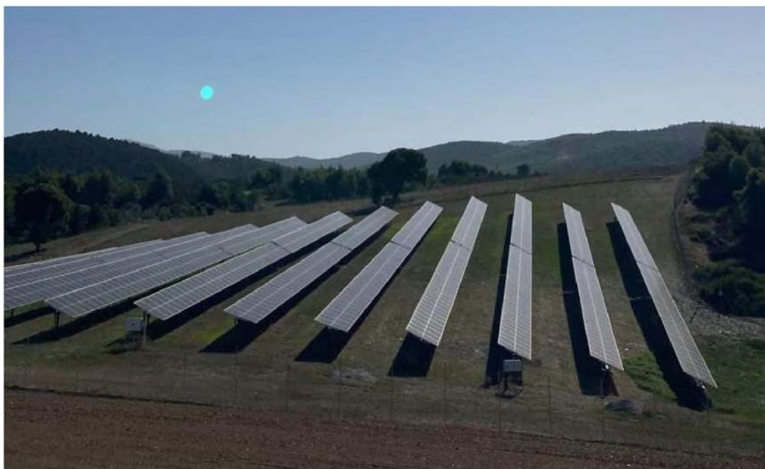
Εικόνα 2.15: Φωτοβολταϊκό πάρκο με κάθετη διάταξη (portrait) στην Εύβοια.
