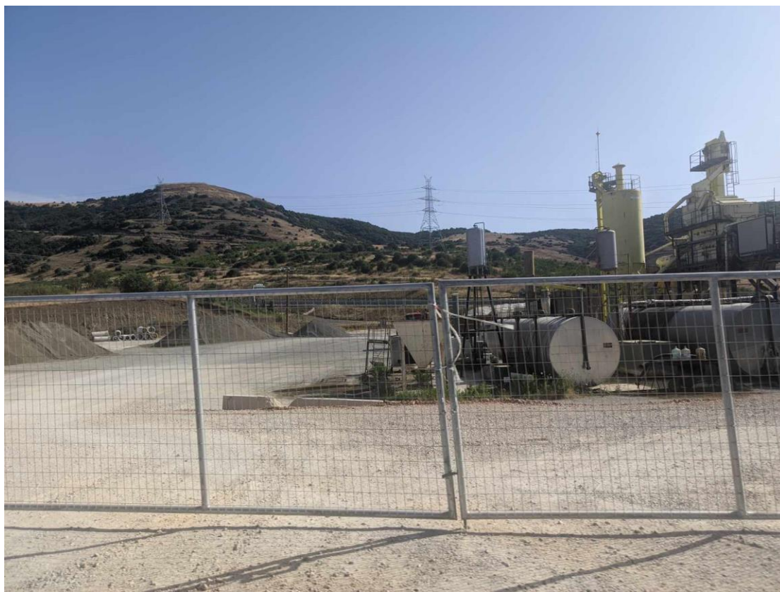
Εικόνα 3. Εργοτάξιο του Ε65
