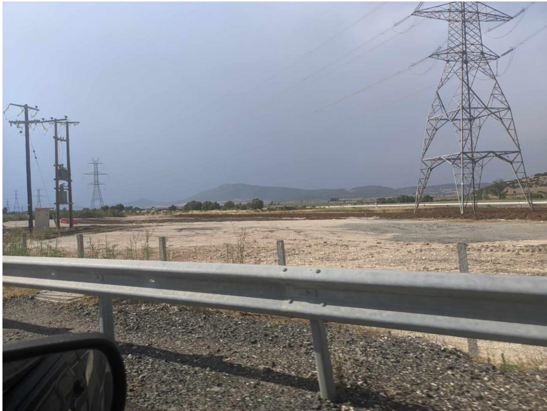
Εικόνα 9. Πυλώνες ρεύματος στο εργοτάξιο του E65
