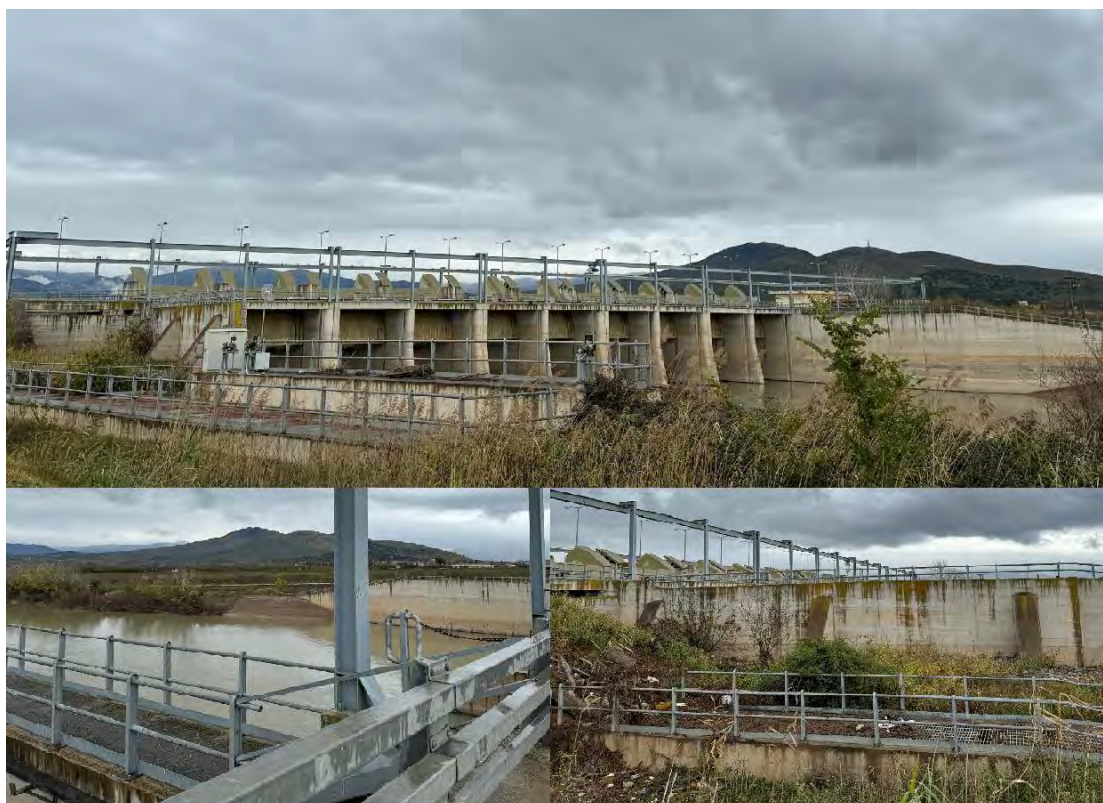
Εικόνα 14 : Το Φράγμα Γυρτώνης, με τα θυροφράγματα και τη σκάλα διέλευσης των ιχθύων
