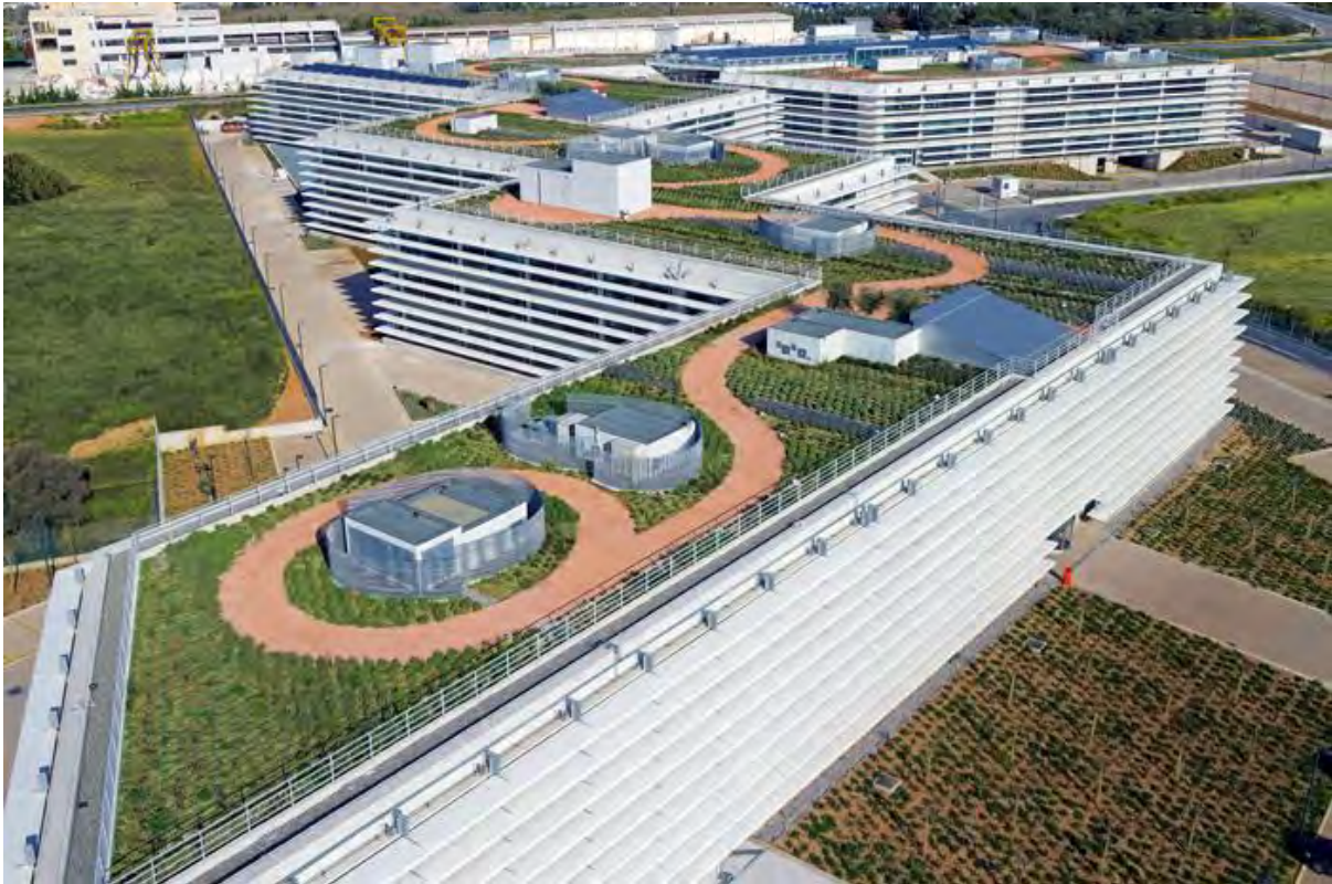
Εικόνα 24: Το πράσινο συγκρότημα κτιρίων Karela Office Park. Πηγή: https://www.fortunegreece.com/ .
