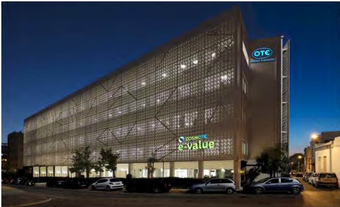
Εικόνα 22: Το πράσινο κτίριο της Cosmote e-Value στο Κεραμεικό. Πηγή: https://buildinggreen.gr .
