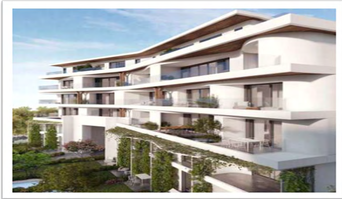
Εικόνα 27: Κτίριο κατοικιών «Oxygen». Πηγή: https://ktirio.gr/ .
