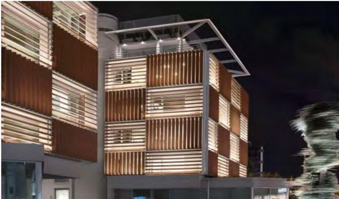
Εικόνα 23: Το πράσινο συγκρότημα κτιρίων Green Plaza της GRIVALIA. Πηγή: https://www.liberal.gr/ .
