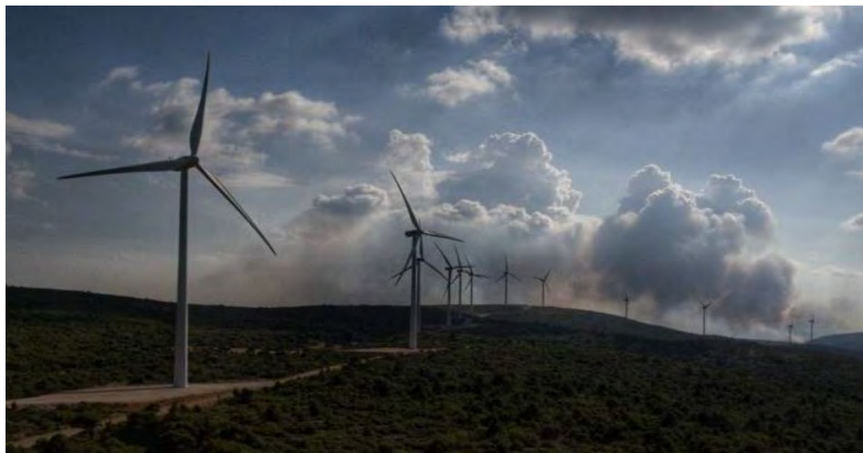
Εικόνα 10 - Ανεμογεννήτριες σε κορυφή βουνού
