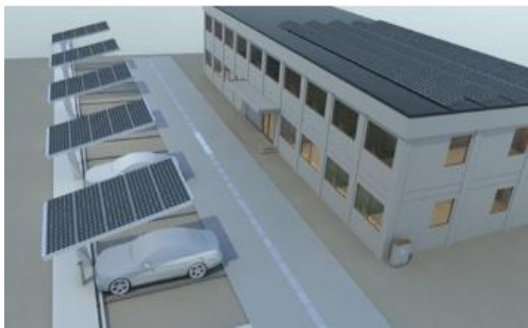
Εικόνα 2: Απεικόνιση ενός σταθμού φόρτισης ηλεκτρικού οχήματος (EV) με ηλιακή ενέργεια που βρίσκεται σε χώρο εργασίας. Τα ηλεκτρικά οχήματα φορτίζονται χρησιμοποιώντας φωτοβολταϊκά (PV) πάνελ που είναι εγκατεστημένα στην ταράτσα αλλά και ως ηλιακό υπόστεγο. ( M. Leendertse).
