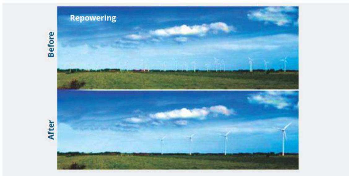
Εικόνα 8: Οπτική αποτύπωση πριν και μετά την Αναδυνάμωση
