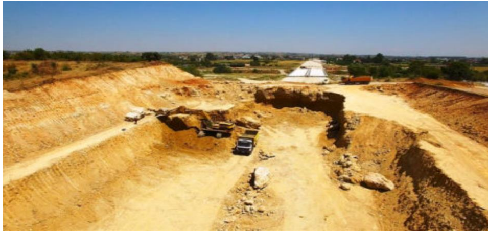
Εικόνα 3. Εκσκαφές ορυγμάτων (πηγή: https://www.barlosergon.gr/drastiriotites-ve/ )
