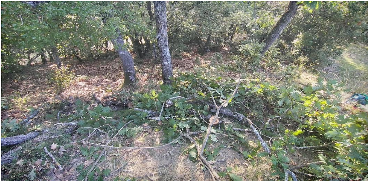
Εικόνα 1. Κοπή και εκρίζωση δένδρων (πηγή: προσωπικό αρχείο)
