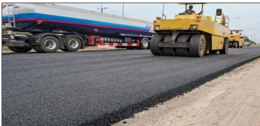
Εικόνα 6 Ασφαλτόστρωση δρόμου χρησιμοποιώντας απόβλητα ελαστικών (Πηγή: Pirakasam et al., 2022).
