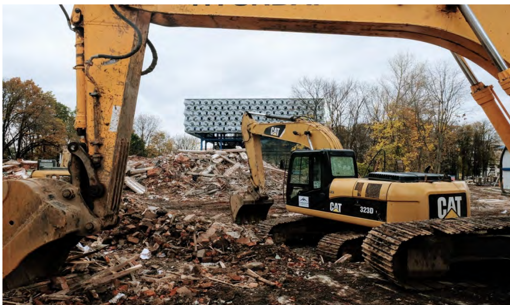
Εικόνα 8 απόβλητα εκσκαφών, κατασκευών και κατεδαφίσεων
