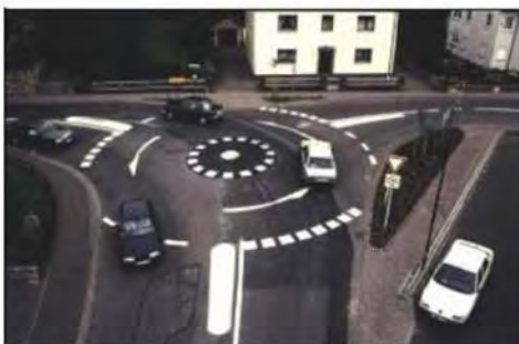
Εικόνα 2.11 : Κομβίδια με κεντρική νησίδα πλήρως διελεύσιμη από φορτηγά
