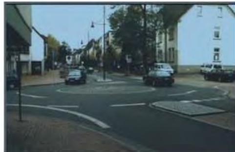
Εικόνα 2.11 : Κομβίδια με κεντρική νησίδα πλήρως διελεύσιμη από φορτηγά
