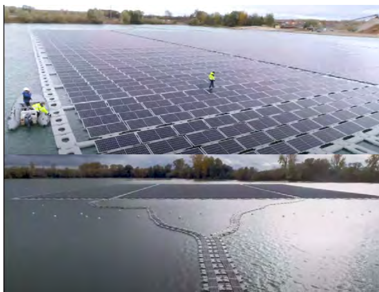
Εικόνα 22 - Τοποθέτηση πλαισίων και μέθοδος σύνδεση καλωδίων
