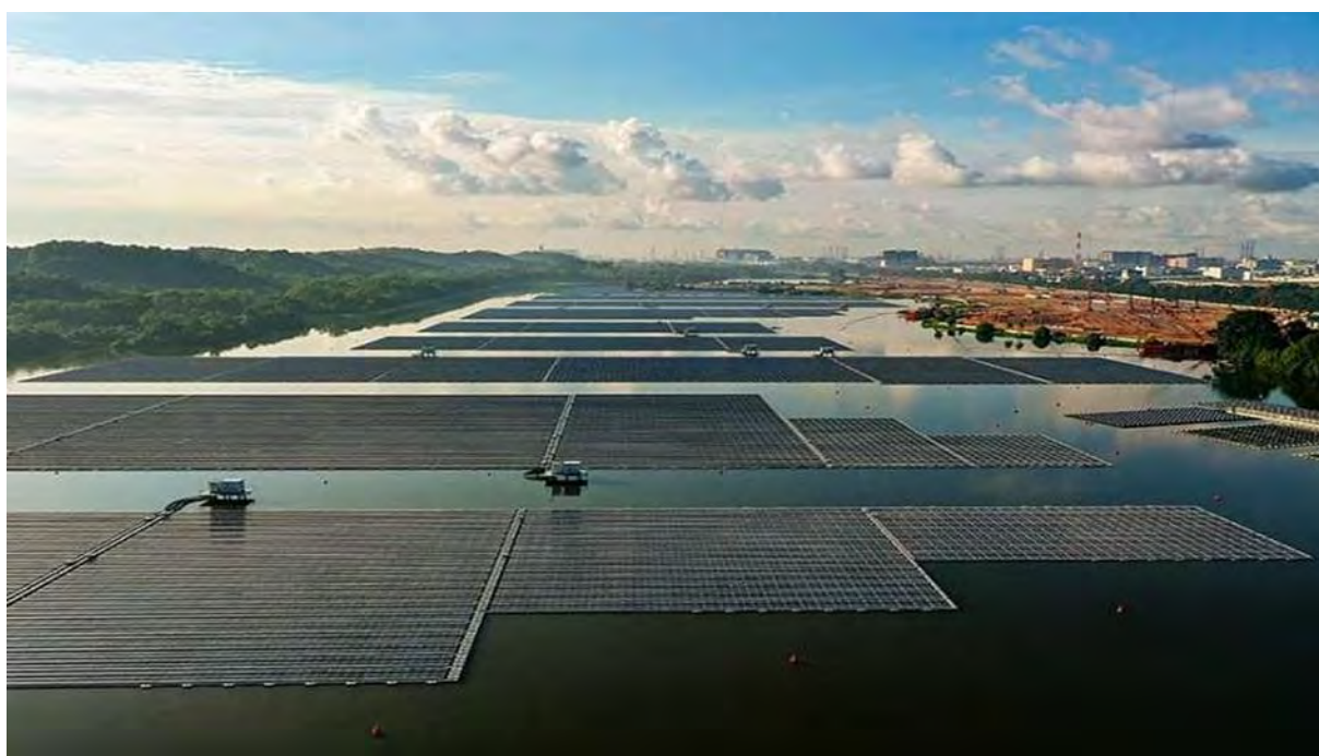
Εικόνα 16 - Πλωτό φ/β πάρκο Σιγκαπούρη
