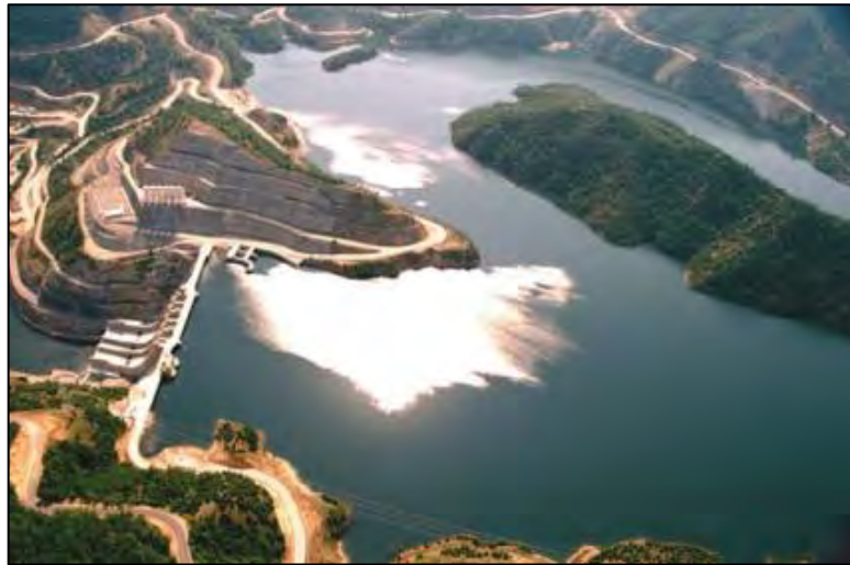
Εικόνα 2.14 : Φράγμα Πλατανόβρυσης, Νέστος (Ντακούλας Π., Π.Θ.)
