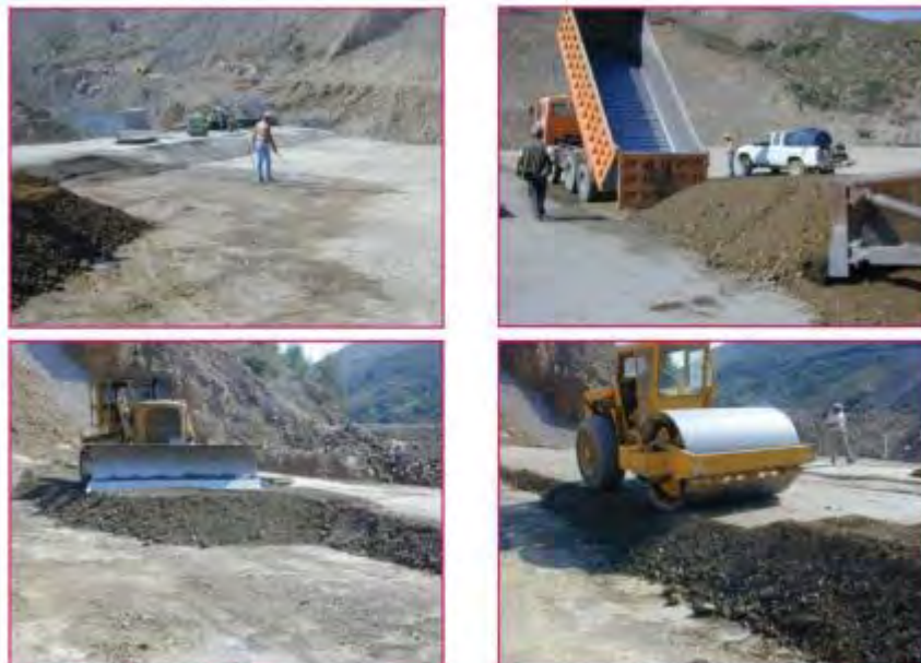
Εικόνα 3.3 : Στάδια κατασκευής φράγματος ΑΚΣΕ (Μουτάφης Ν., 2009)
