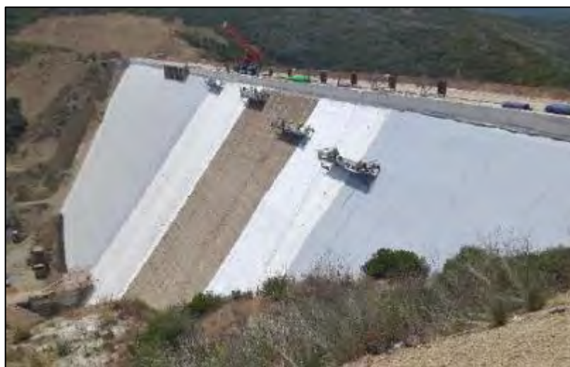
Εικόνα 3.4 : Εφαρμογή γεωμεμβράνης στο φράγμα Φιλιατρινού, Πελοπόννησος (Μουτάφης & Θανόπουλος, 2015)
