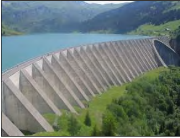
Εικόνα 2.11 : Φράγμα Roselend ( H=150m ), Γαλλία (Ντακούλας Π., Π.Θ.)
