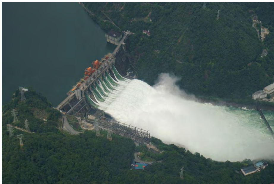
Εικόνα 19: Εκκένωση πλημμύρας στο φράγμα του ποταμού Xin'an, κατά τις πλημμύρες του 2020 στην Κίνα.
