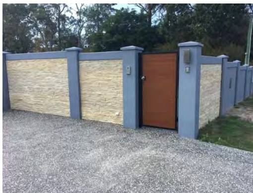
Εικόνα 13. Περίφραξη από σκυρόδεμα(railwaysleepers)
