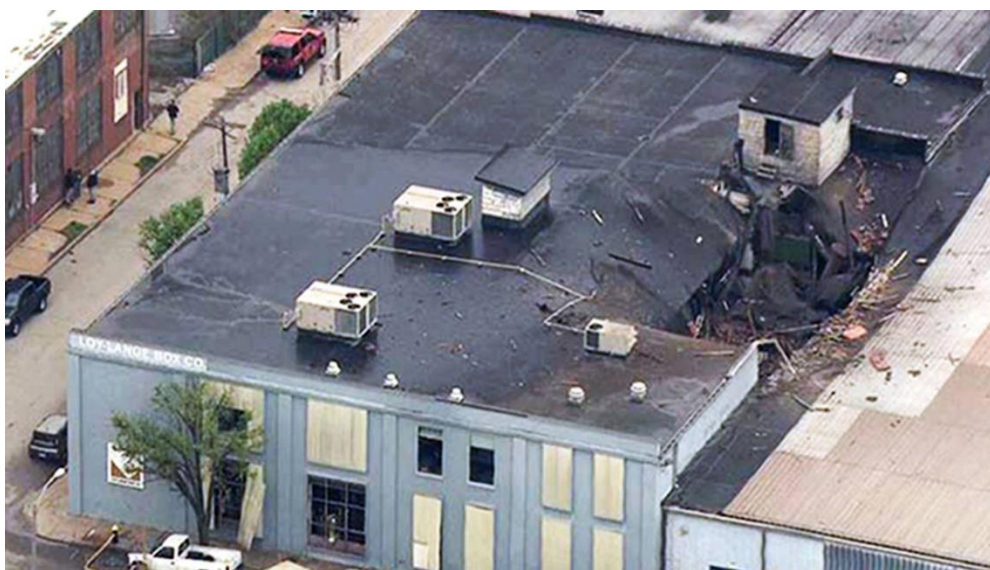
Εικόνα 24: Εγκαταστάσεις της Loy Lange Box Co μετά την αστοχία του δοχείου [61]
