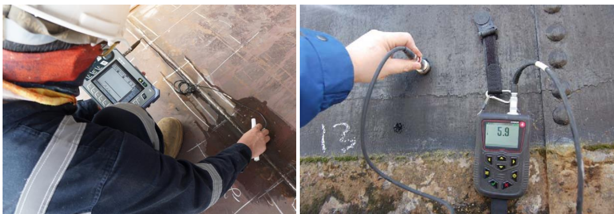
Εικόνα 64: (α) Εφαρμογή UT για ασυνέχειες [42], (β) Παχυμετρήσεις ελάσματος με UT [42]
