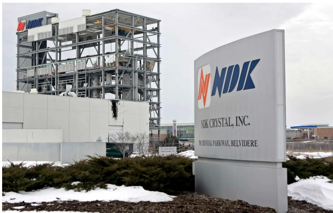
Εικόνα 22: Κτηριακές εγκαταστάσεις της NDK Crystals Inc.[60]
