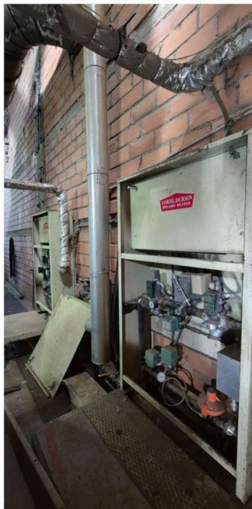
Εικόνα 3.2: Διάταξη πύργων ξήρανσης σύσπορου βάμβακος (αριστερά) – Καυστήρας υγραερίου (δεξιά)
