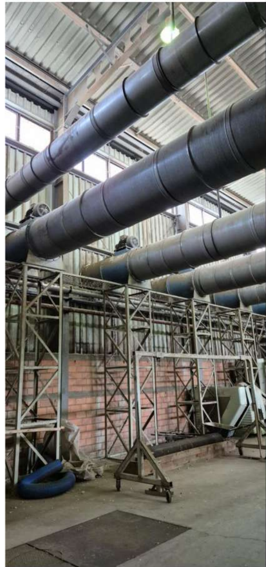
Εικόνα 3.5: Lint cleaner Lummus 108 (αριστερά) – Αξονικοί απορροφητήρες Lint cleaner (δεξιά)
