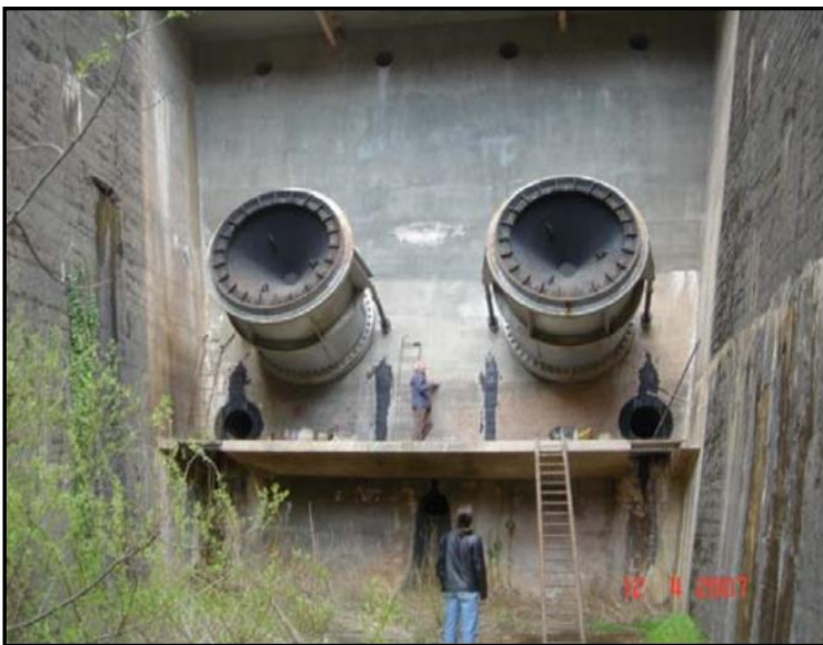
Εικόνα 6.Δύο Εκκενωτές και Υπερχειλιστές του φράγματος Ταυρωπού.
