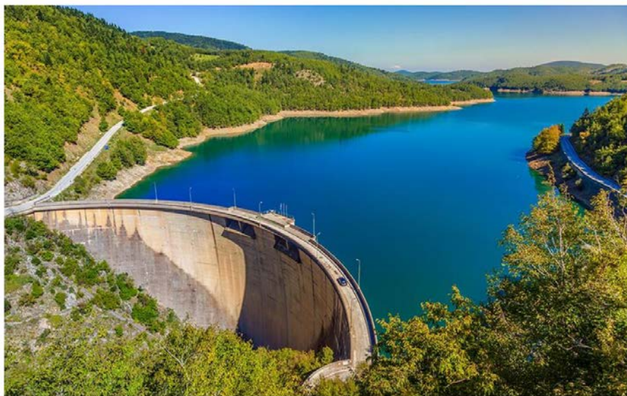
Εικόνα 2. Φράγμα Ταυρωπού στη Καρδίτσα , τοξωτό φράγμα διπλής καμπυλότητας
