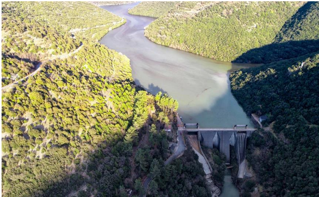
Εικόνα 3. Φράγμα Λάδωνα στην Αρκαδία , αντιρηδωτό φράγμα
