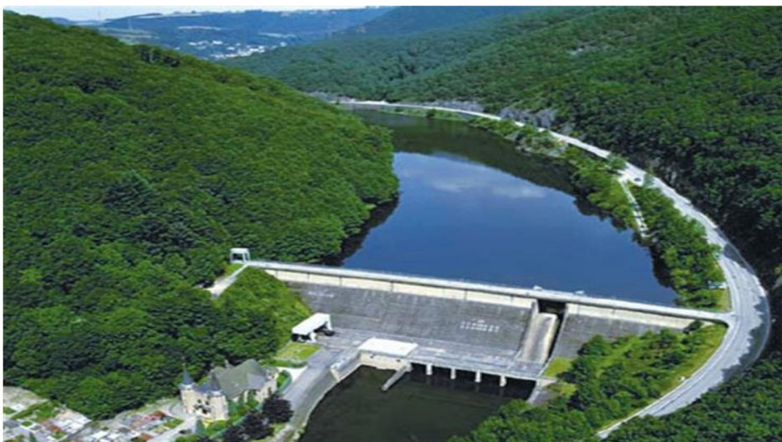
Εικόνα 5. Υδροηλεκτρικό χωμάτινο φράγμα Ιλαρίωνα, Κοζάνη – Έργο πολλαπλής σκοπιμότητας.
