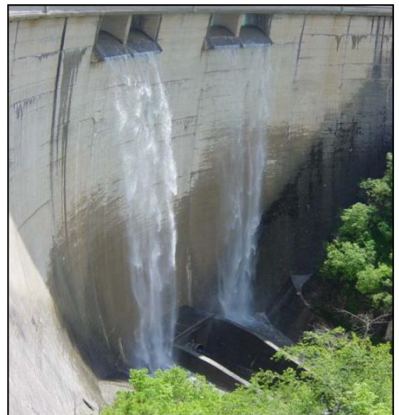
Εικόνα 6.Δύο Εκκενωτές και Υπερχειλιστές του φράγματος Ταυρωπού.
