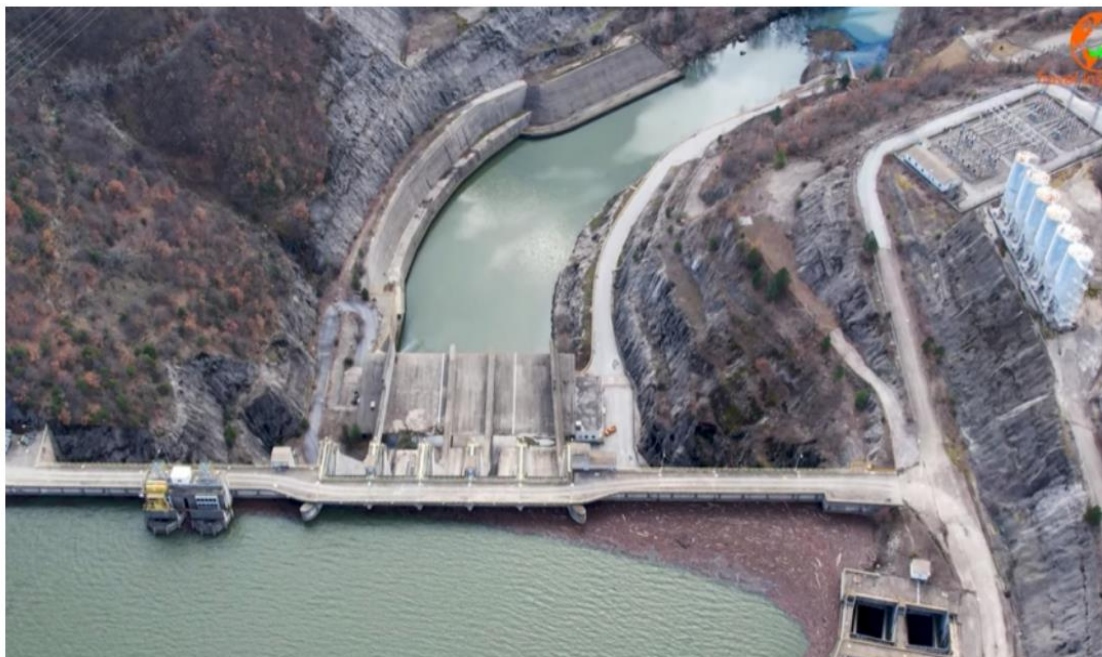
Εικόνα 4. Φράγμα Θησαυρού, ορεινά της Δράμας, το μεγαλύτερο λιθορριπτό φράγμα της Ελλάδας.
