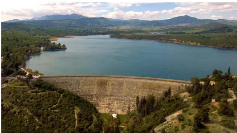
Εικόνα 1 Φράγμα Μαραθώνα, φράγμα βαρύτητας
