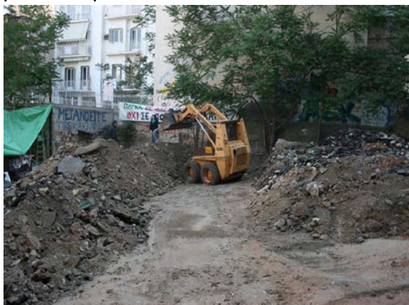
Εικ. 3. Εργασίες για τη μετατροπή του χώρου σε πάρκο
