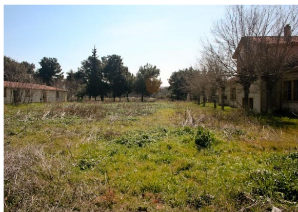
Εικ. 14. Άποψη του χώρου του πρώην στρατοπέδου Καρατάσιου (πριν)
