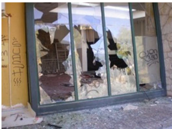
Εικ. 26. Κατάσταση του χώρου (πριν)
