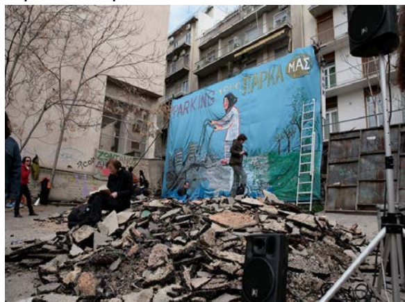
Εικ. 4. Εργασίες για τη μετατροπή του χώρου σε πάρκο
