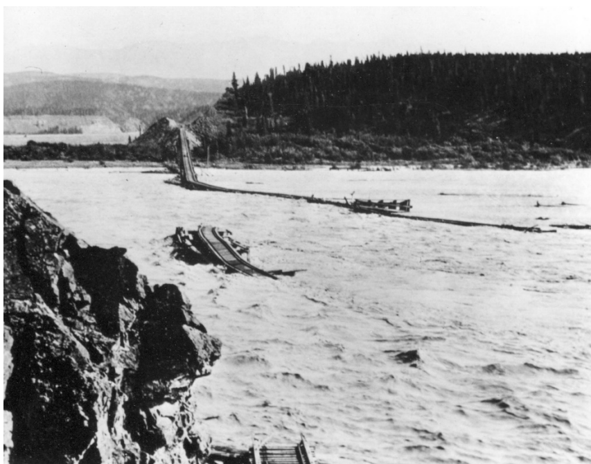
Σχήμα 1.2 Ολοκληρωτική καταστροφή της γέφυρας του ποταμού Copper στην Αλάσκα λόγω πλημμύρας 2
