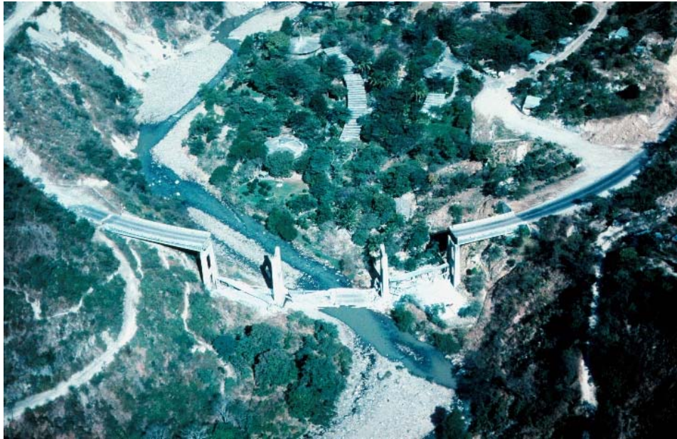
Σχήμα 1.4 Κατάρρευση τριών ανοιγμάτων της γέφυρας Agua Caliente, μακρινή λήψη 4
