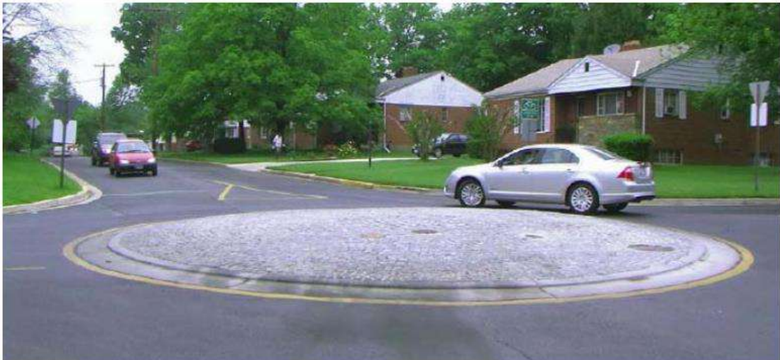
Εικόνα 2-9: Κομβίδιο κυκλικής κίνησης σε υφιστάμενη διασταύρωση με υπερυψωμένη κεντρική νησίδα (συνιστάται υπερύψωση max 12,5 cm στο κέντρο) Πηγή: (ΟΜΟΕ-K3, 2011)
