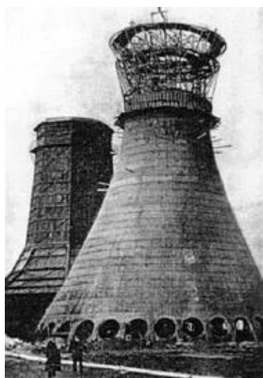
Εικόνα 2.4: Ο πρώτος υπερβολοειδής πύργος ψύξης, Heerlen 1918 [11]
