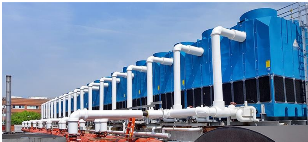
Εικόνα 2.5: Πύργοι ψύξης στο νοσοκομείο Lincoln της New York City [13]
