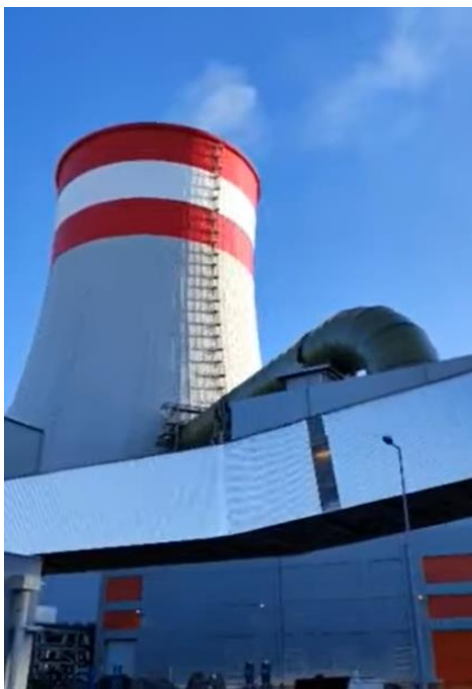
Εικόνα 2.9: Πύργος ψύξης φυσικής ροής – Πτολεμαΐδα [26]
