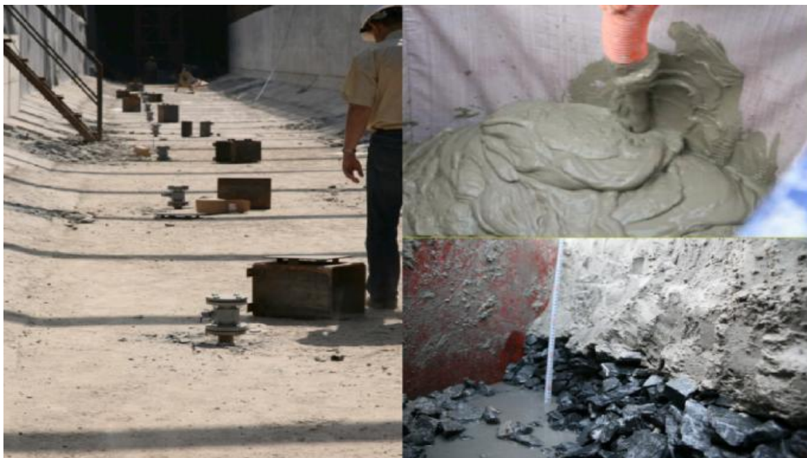
Εικόνα 4.21 Οι βαλβίδες έγχυσης ενέματος κάτω από τη βάση, (αριστερή εικόνα), το μείγμα ενέματος (πάνω δεξιά), το κιβώτιο δοκιμής για τις ιδιότητες του ενέματος (κάτω δεξιά) (Πηγή: Olsen, et al. 2022).
