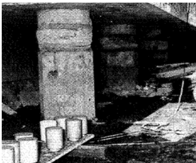
Εικόνα 4.13 Πάσσαλος με ρυθμιζόμενη κεφαλή (επιθεώρηση) (Πηγή: Olsen, et al. 2022).
