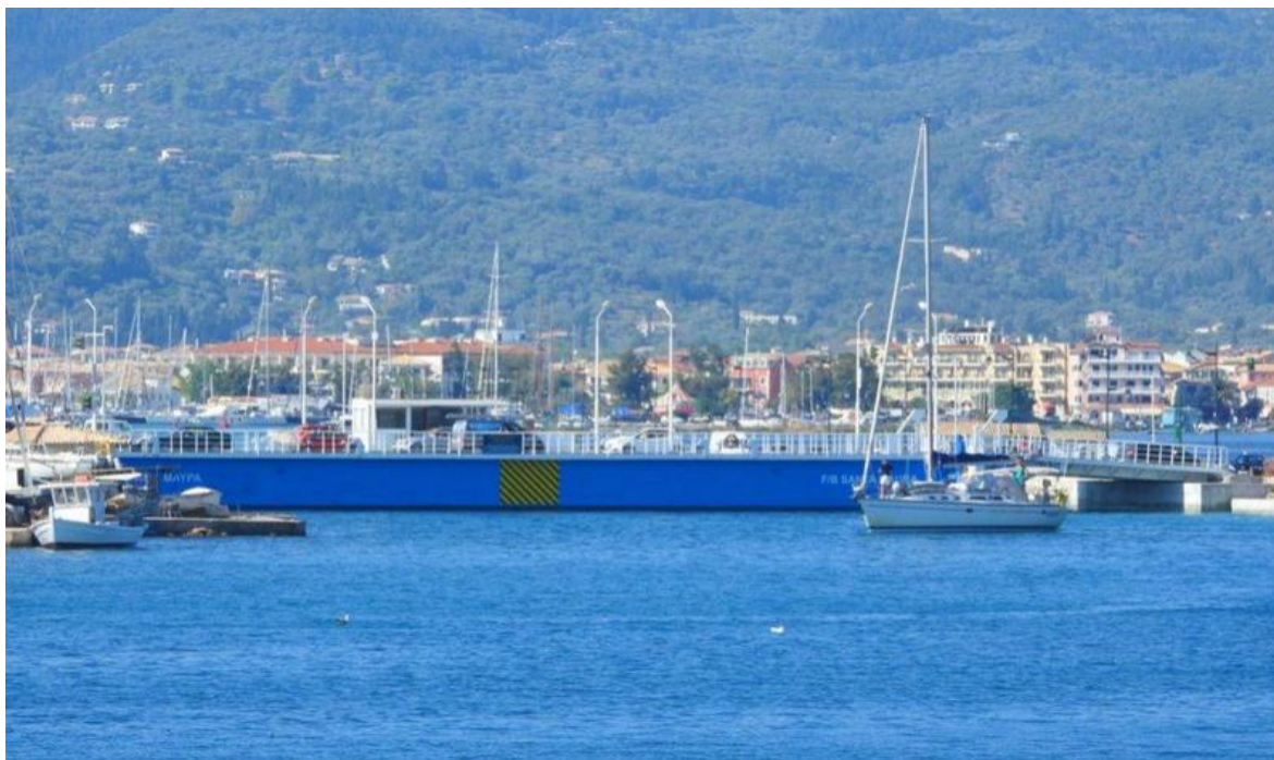
Εικόνα 6.6 Η νέα πλωτή γέφυρα σε λειτουργία (Πηγή: Σάντα, 2019).
