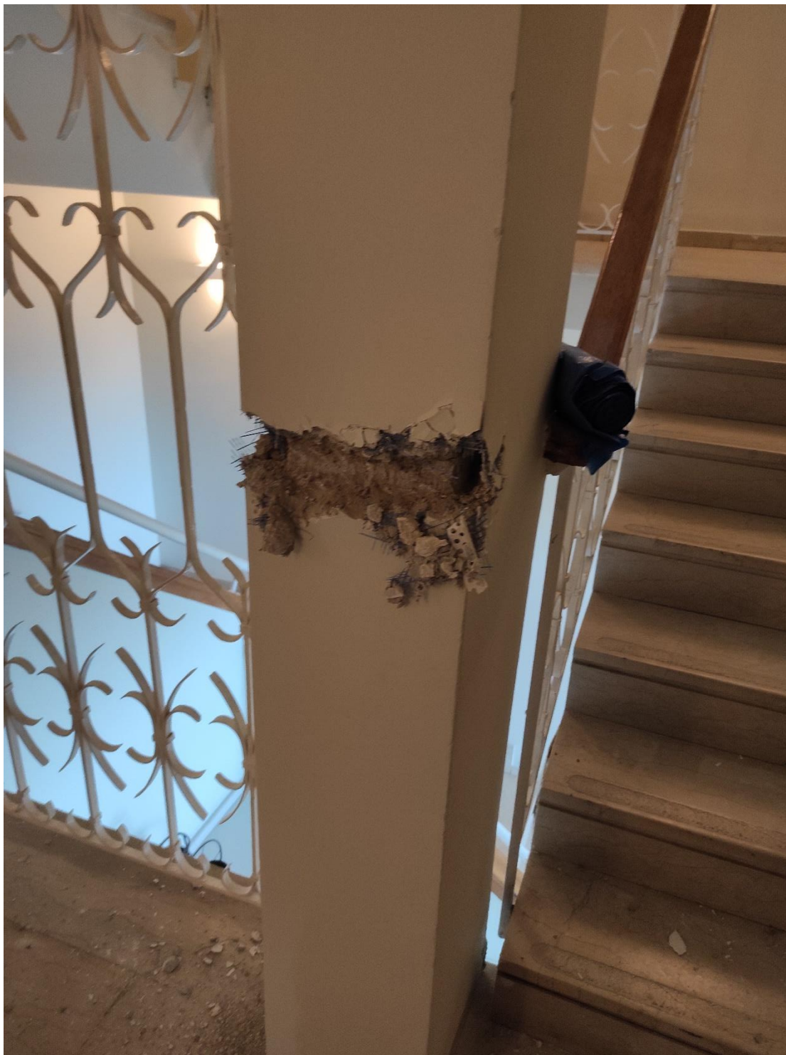
Σχήμα 2.7: Αποκάλυψη πραγματικής διάστασης κολόνας μέσω διένεξης
