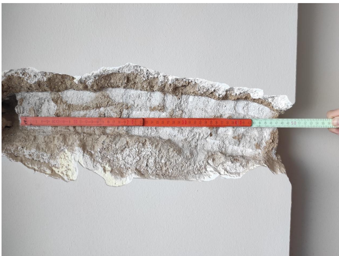
Σχήμα 2.9: Μέτρηση επικάλυψης και πραγματικής διάστασης υποστυλωμάτων
