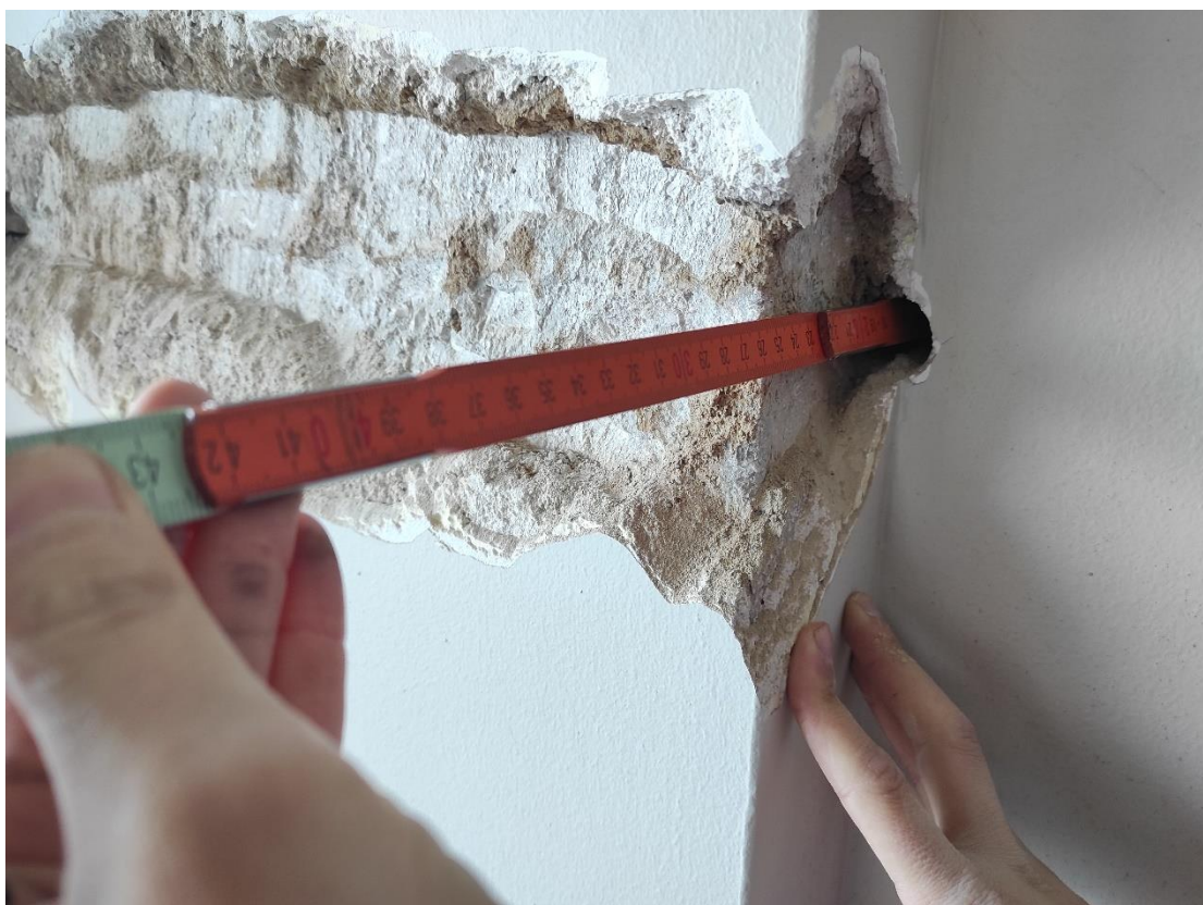
Σχήμα 2.8: Μέτρηση επικάλυψης και πραγματικής διάστασης υποστυλωμάτων
