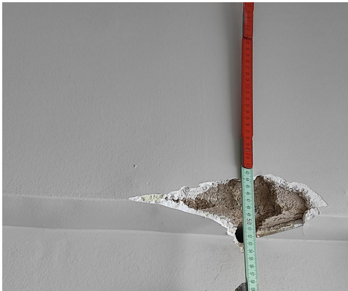
Σχήμα 2.10: Μέτρηση Κρέμασης και επικάλυψης Δοκού
