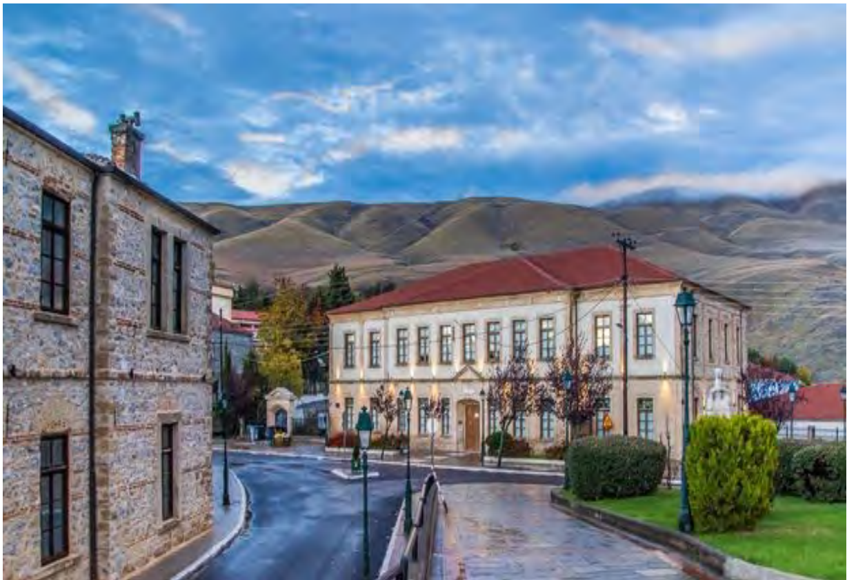
Εικόνα 69 Τραμπάντζιο Γυμνάσιο, όψη.
