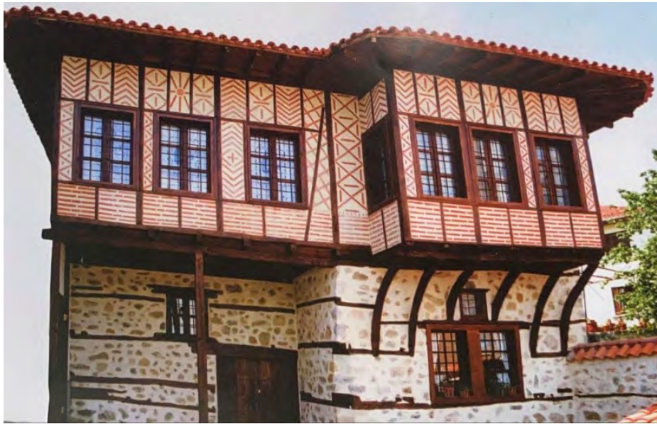
Εικόνα 64 Αρχοντικό Ζαμάντη-Τάτη, μετά την αποκατάσταση.
