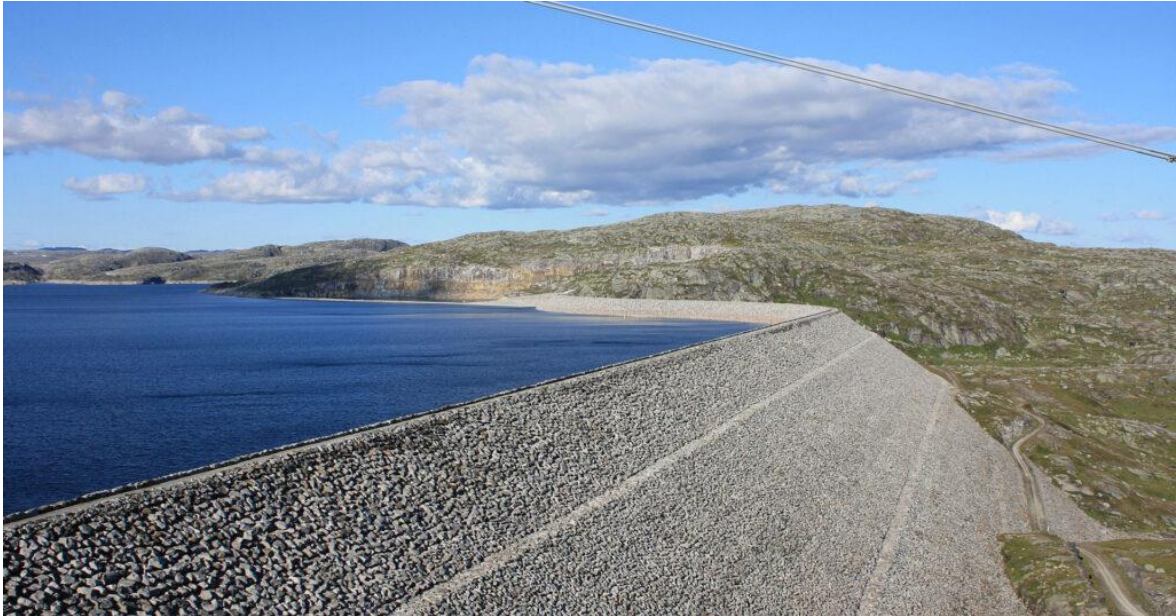
Εικόνα 7.3.3: Το φράγμα Storvassdammen είναι μέρος του Ulla-Førre, ενός υδροηλεκτρικού σταθμού που απλώνεται στους δήμους Hjelmeland, Suldal και Bylke της Νορβηγίας.
