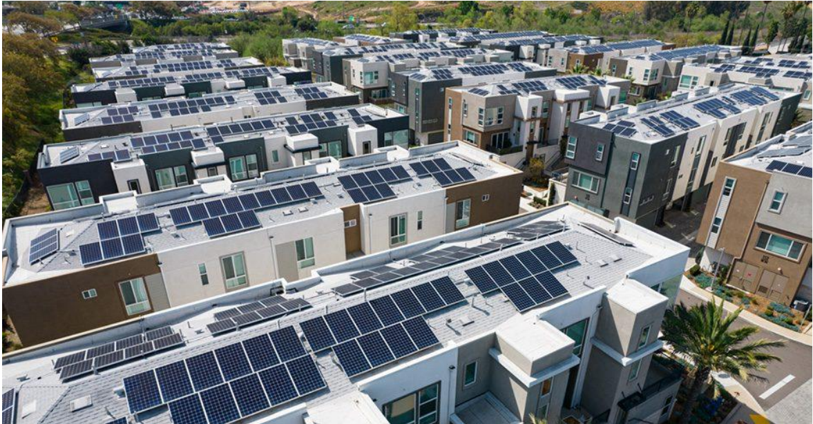
Εικόνα 7.1.1: Φωτοβολταϊκό σύστημα πολλαπλών οικογενειών στην πόλη του Σαν Μάρκος, στα βόρεια της κομητείας του Σαν Ντιέγκο.
