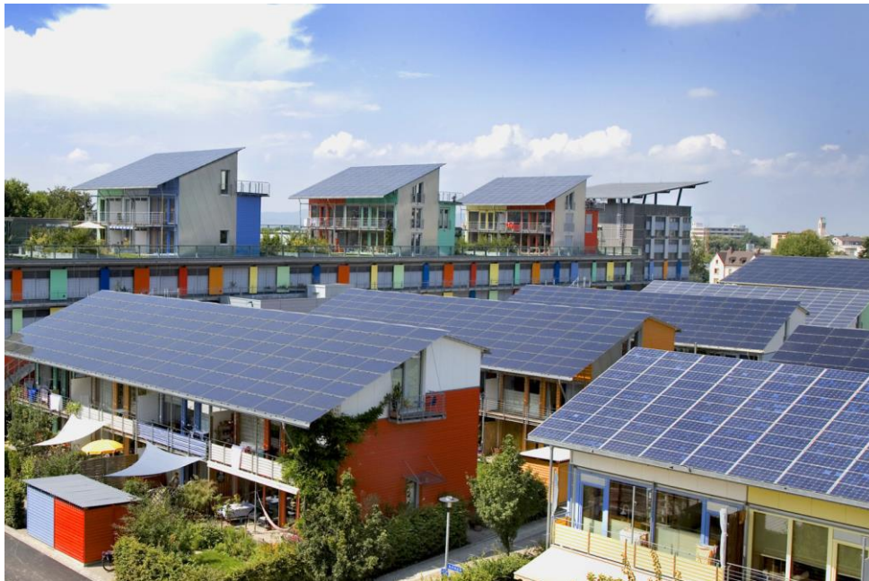
Εικόνα 7.1.2: Ηλιακές εγκαταστάσεις στέγης στο Φράιμπουργκ, Γερμανία.
