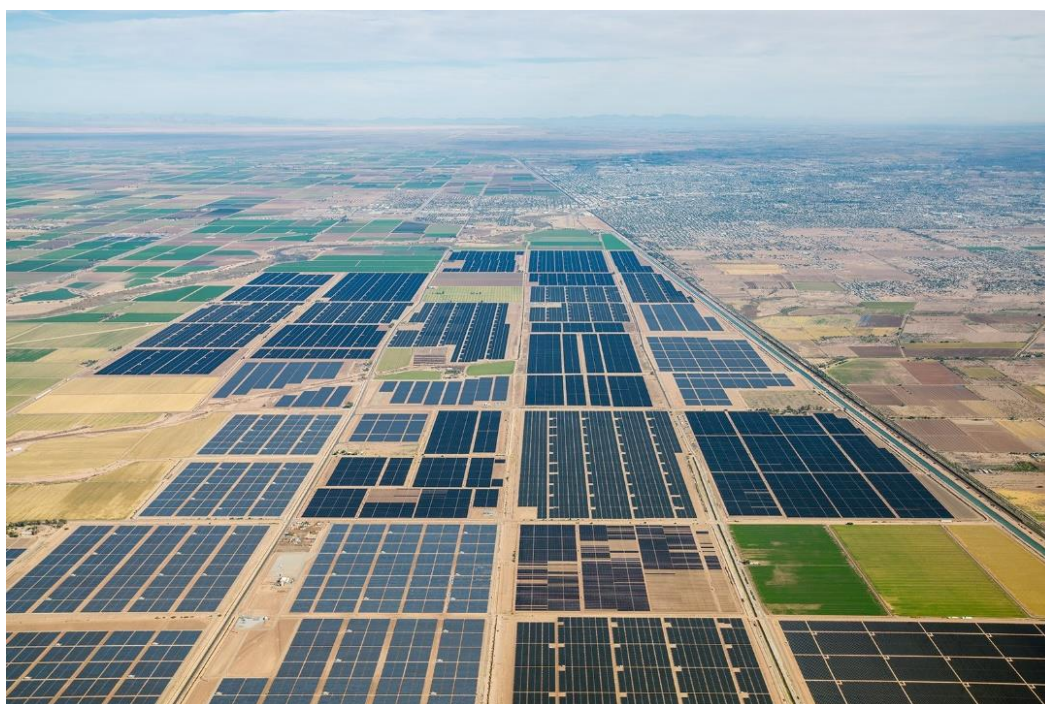
Εικόνα 7.1.3: Το ηλιακό πάρκο Mount Signal 2 στο Καλέξικο, Καλιφόρνια.
