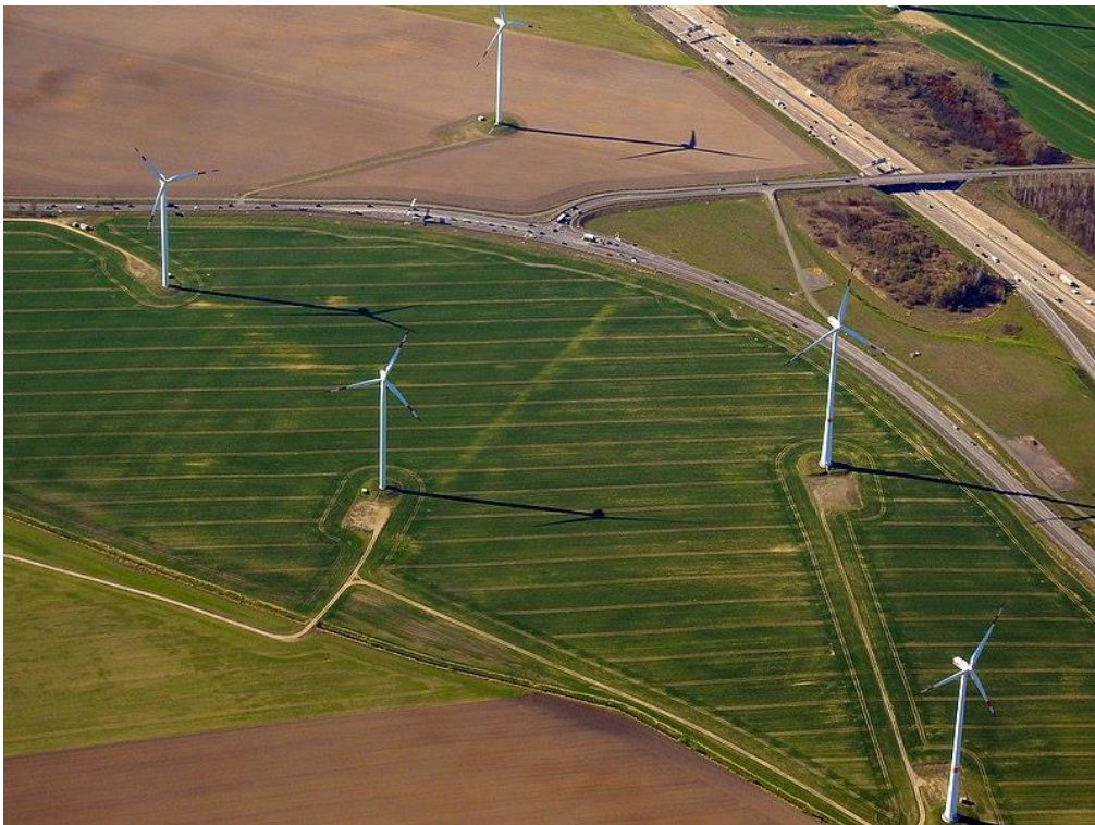
Εικόνα 7.2.3: Αιολικό πάρκο στο Λίντερμπεργκ, Γερμανία.
