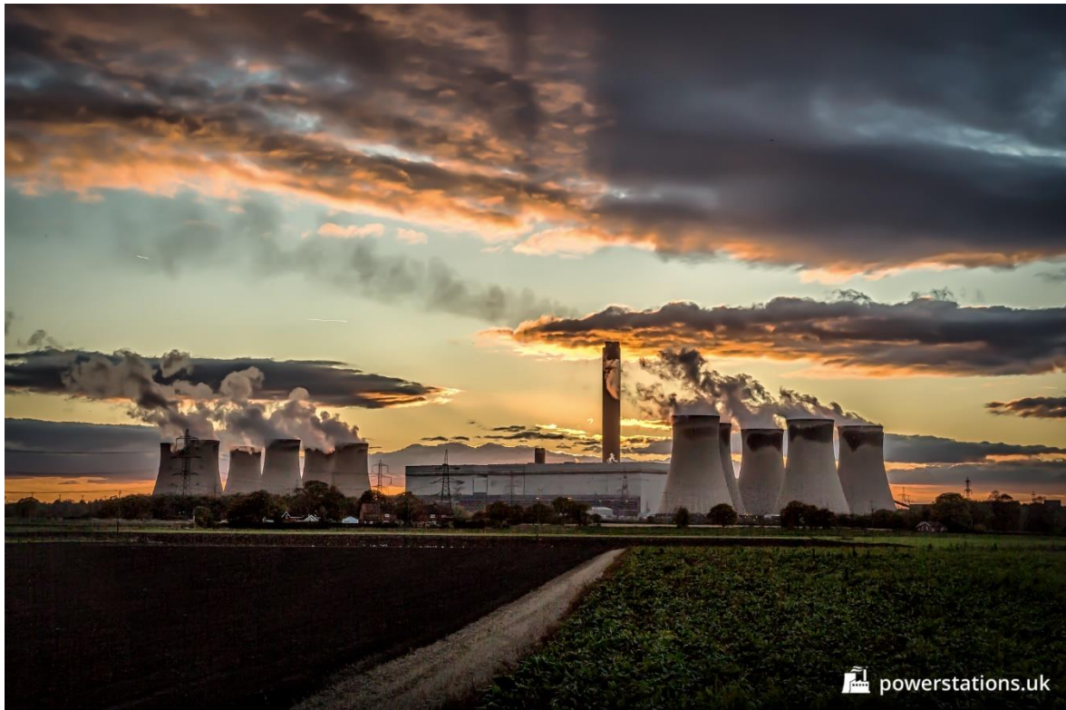
Εικόνα 7.5.2: Ο Ηλεκτρικός Σταθμός Drax στο Βόρειο Γιorkσάιρ, ΗΒ.
