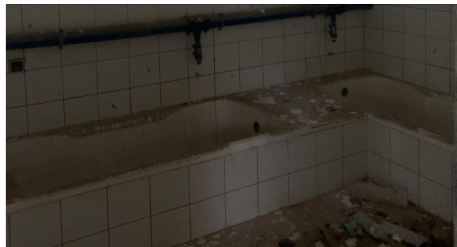
Εικόνα 21: Φωτογραφία των μπανιέρων στο εσωτερικό των δωματίων
