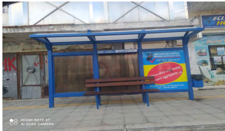
Εικόνα 34: Έξυπνο Στέγαστρο στο Πολύκαστρο Πηγή: Ιδία Επεξεργασία
