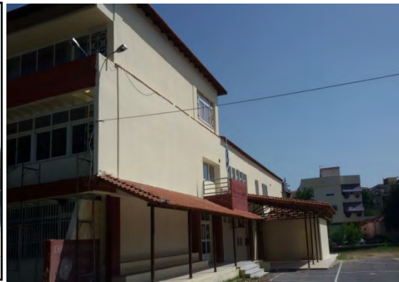
Εικόνα 39: Πλάγια όψη Γυμνασίου Πολυκάστρου με ολοκληρωμένη την εξωτερ. θερμομόνωση Πηγή: Διεύθυνση Τεχνικών Υπηρεσιών
