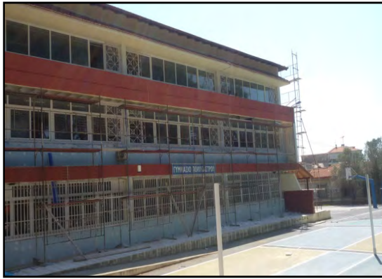
Εικόνα 38: Τοποθέτηση εξωτερικής θερμομόνωσης στο Γυμνάσιο Πολυκάστρου Πηγή: Διεύθυνση Τεχνικών Υπηρεσιών
