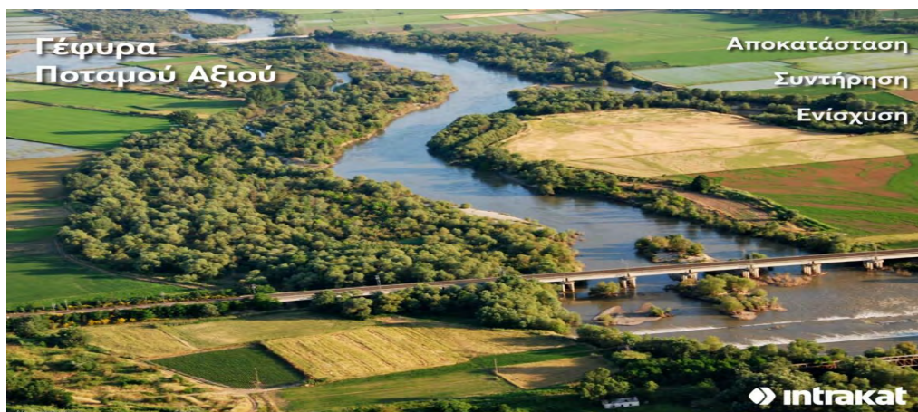
Εικόνα 57: Γέφυρα ποταμού Αξιού
