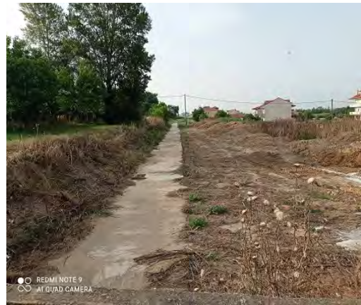
Εικόνα 43: Κατασκευή αντιπλημμυρικού πλακοσκεπή αγωγού στο Πολύκαστρο Πηγή: https://www.karatzova.com/
