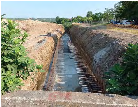
Εικόνα 42: Κατασκευή αντιπλημμυρικού πλακοσκεπή αγωγού στο Πολύκαστρο Πηγή: https://www.karatzova.com/
