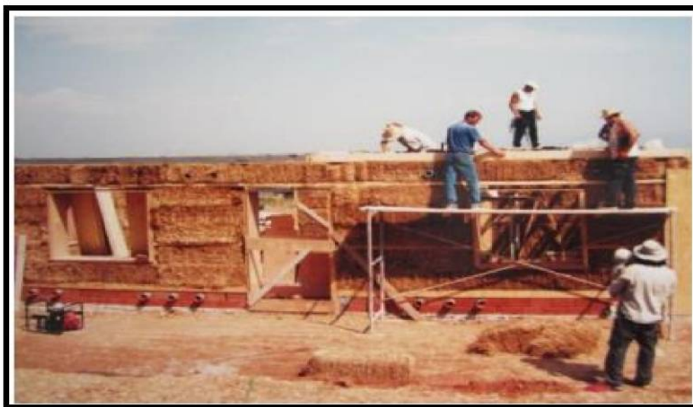
Εικόνα 18 α) Κατασκευή κατοικίας
