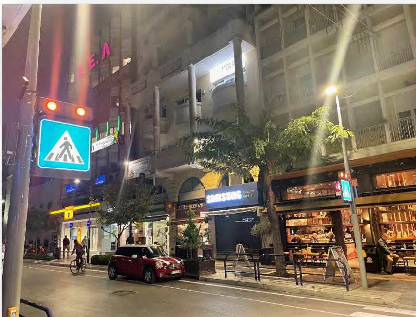
Εικόνα 25: «Έξυπνη» φωτιζόμενη διάβαση με «ανιχνευτή» πεζών στην οδό Κύπρου
