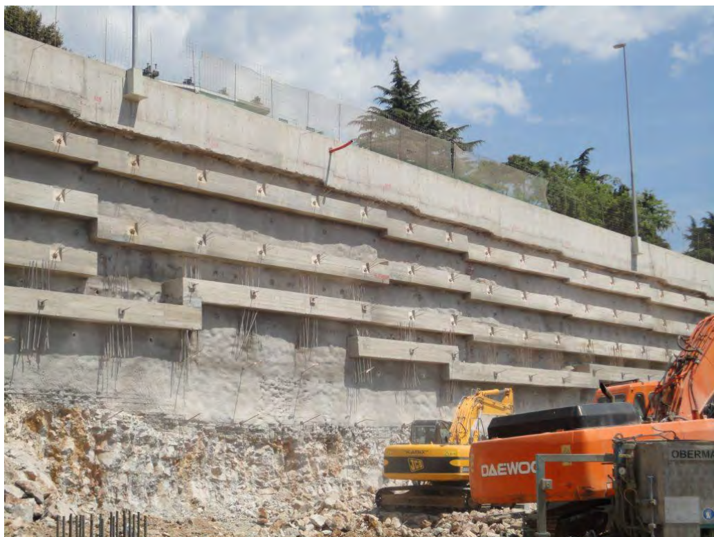
Εικόνα 39. Τοίχος αντιστήριξης με πασσάλους (Butcher, 2021).
