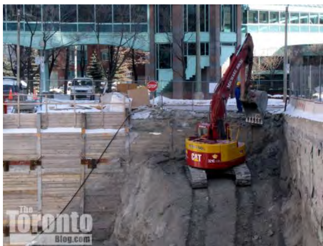
Εικόνα 3. Εκσκαφέας τύπου Caterpillar 321C σκάβει στην κορυφή ενός ψηλού σωρού χώματος στη νοτιοανατολική γωνία της τοποθεσίας ανασκαφής Couture Contos στο Ted Rogers Way στη γειτονιά Bloor Jarvis, στο Τoróntonτο του Καναδά (Anon., 2023).
