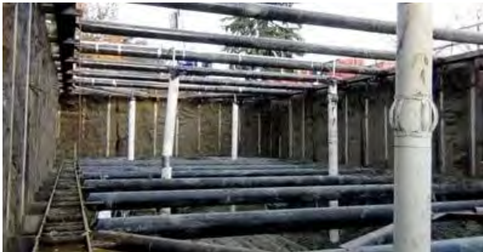
Εικόνα 20. Εκσκαφή με τη μέθοδο της αντιστήριξης (Anon., 2023).
