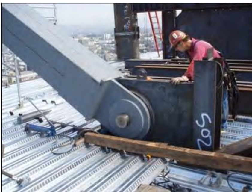
Εικόνα 27. Καρφισωμένη υποστήριξη (Anon., 2023).
