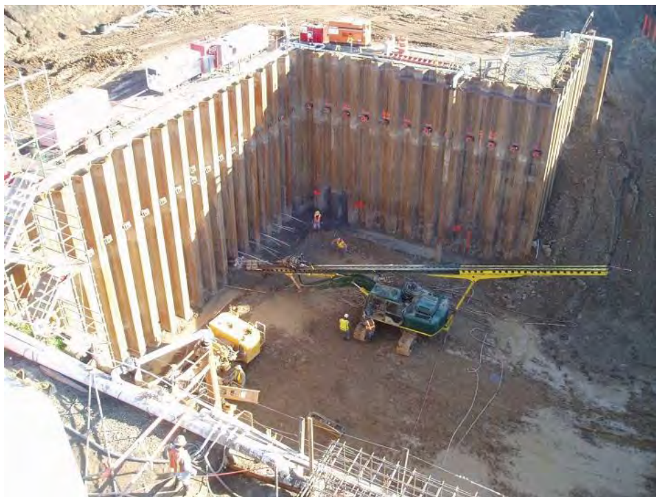
Εικόνα 21. Μέθοδος εκσκαφής με το σύστημα Sheet Pile (Anon., 2023).
