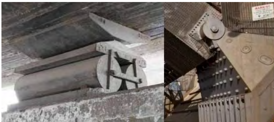
Εικόνα 25. Στηρίγματα κυλίνδρου σε κατασκευή γέφυρας (Anon., 2023).
