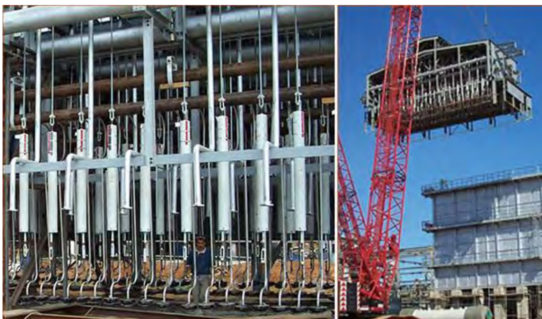
Εικόνα 29. Μέθοδος στηρίγματος ελατηρίου (Anon., 2023).
