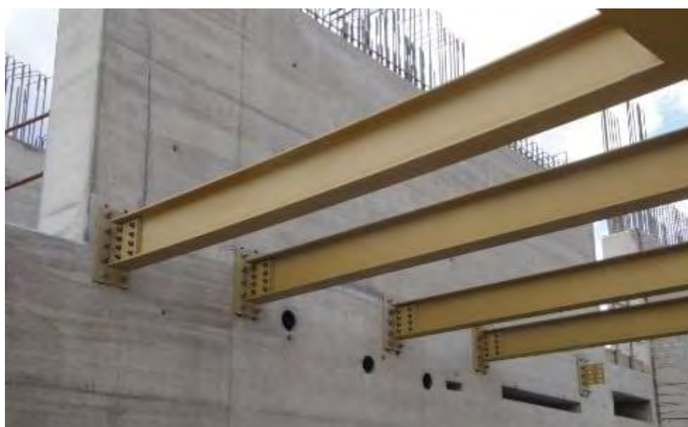
Εικόνα 28. Κατασκευή σταθερού στηρίγματος (Αnon., 2023).
