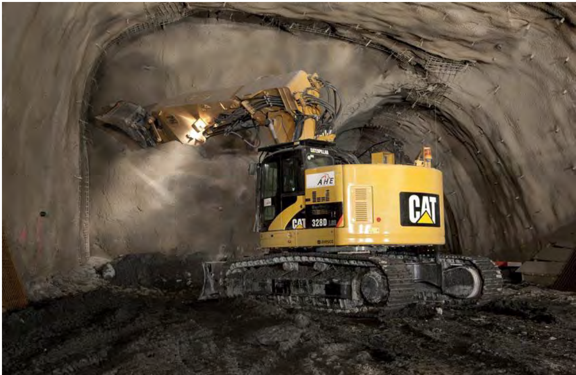
Εικόνα 12. Υπόγεια εκσκαφή (Chen, 2011).
