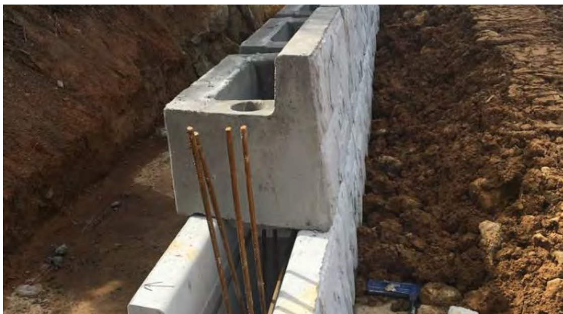
Εικόνα 35. Τοίχος αντιστήριξης με πρόβολου (Bauduin, 2022)
