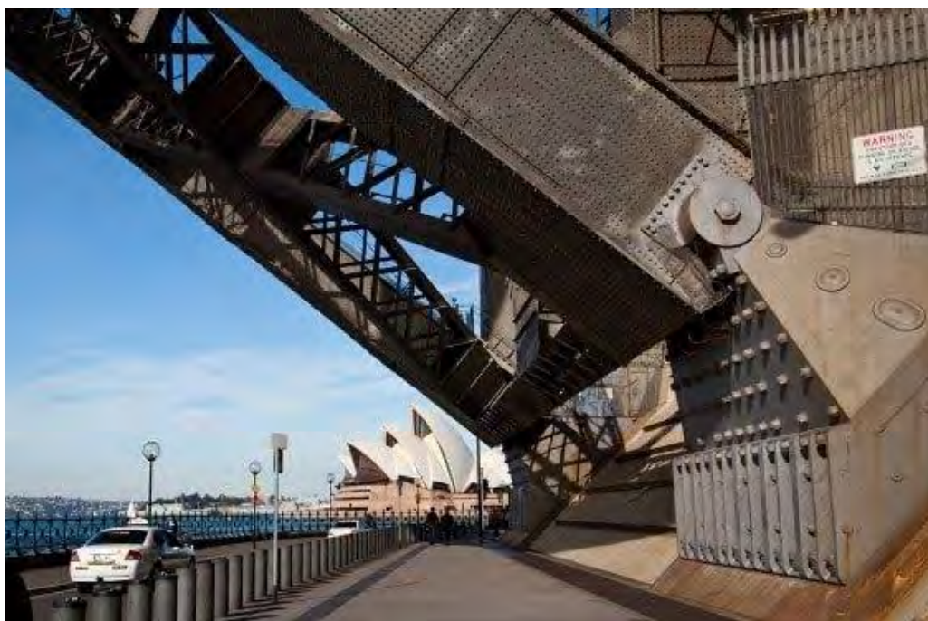
Εικόνα 26. Αρθρωτό στήριγμα σε γέφυρα στο Σίδνεϋ (Anon., 2023).
