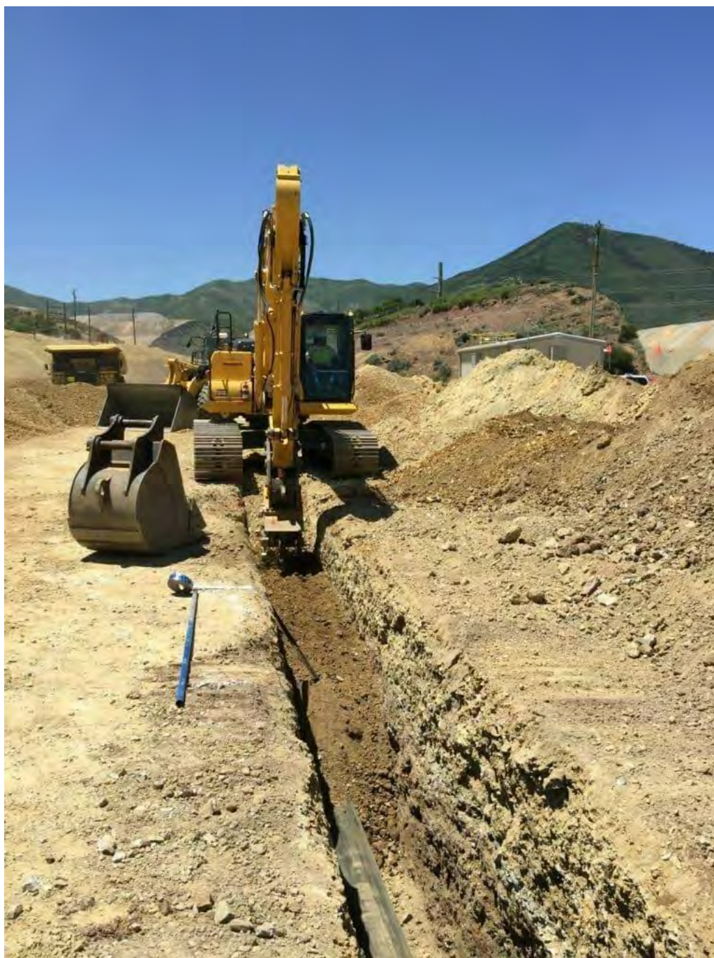
Εικόνα 7. Εκσκαφή Μικρής κλίμακας (Ανοπ., 2023).
