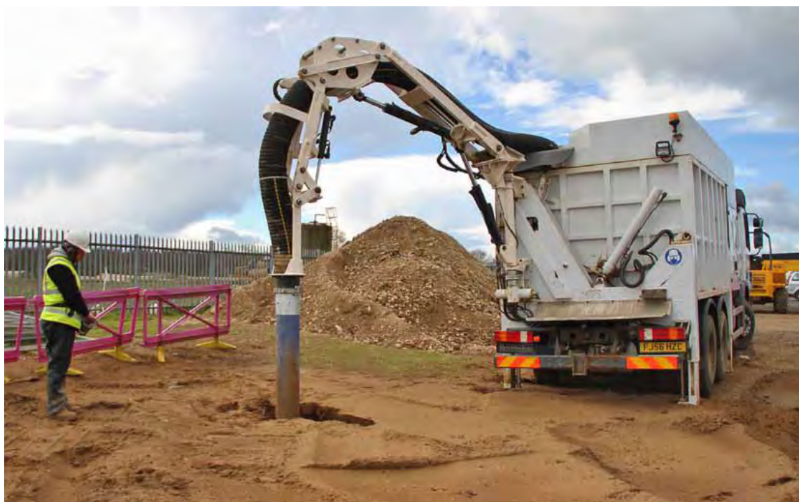
Εικόνα 22. Εκσκαφή με τη χρήση εκσκαφέα κενού (Taing, 2017).
