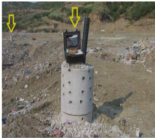
Εικόνα 25 Κατασκευή κατακόρυφου δικτύου.
