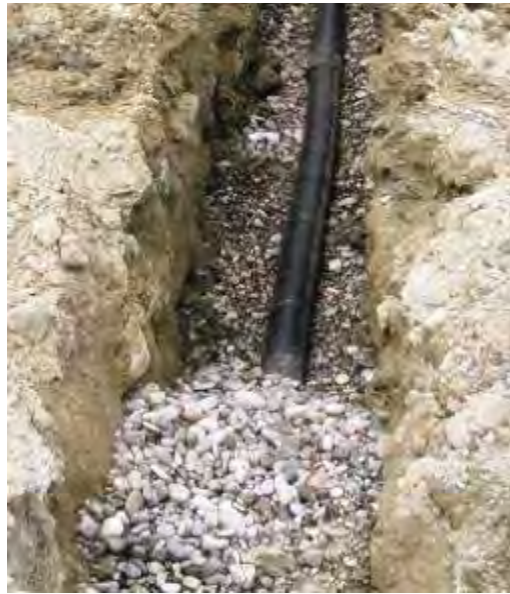
Εικόνα 23 Τοποθέτηση διάτρητου αγωγού .
