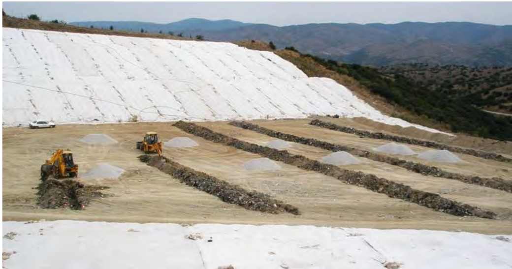
Εικόνα 21 . Κατασκευή οριζόντιου δικτύου 20
