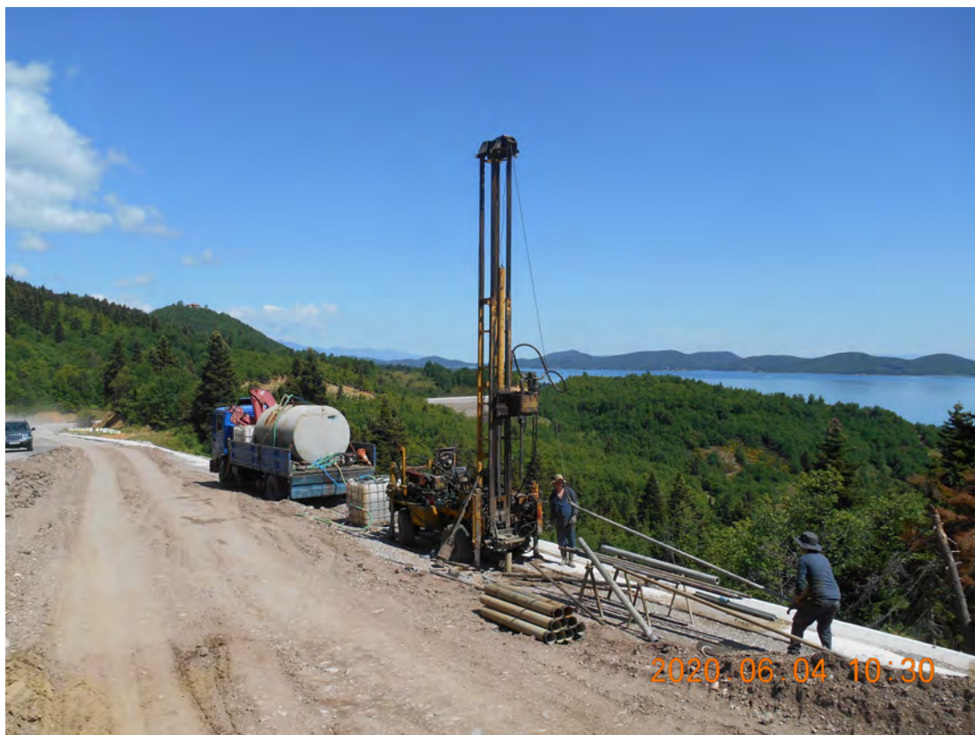
Φωτ. 10: Θέση ανόρυξης της δειγματοληπτικής γεώτρησης Γ-2 στα πλαίσια της Γεωτεχνικής Έρευνας - Μελέτης αποκατάστασης αστοχίας δύο επιχωμάτων στη Χ.Θ. 2+030 & 2+800 στο έργο: Παράκαμψη Νεοχωρίου.
