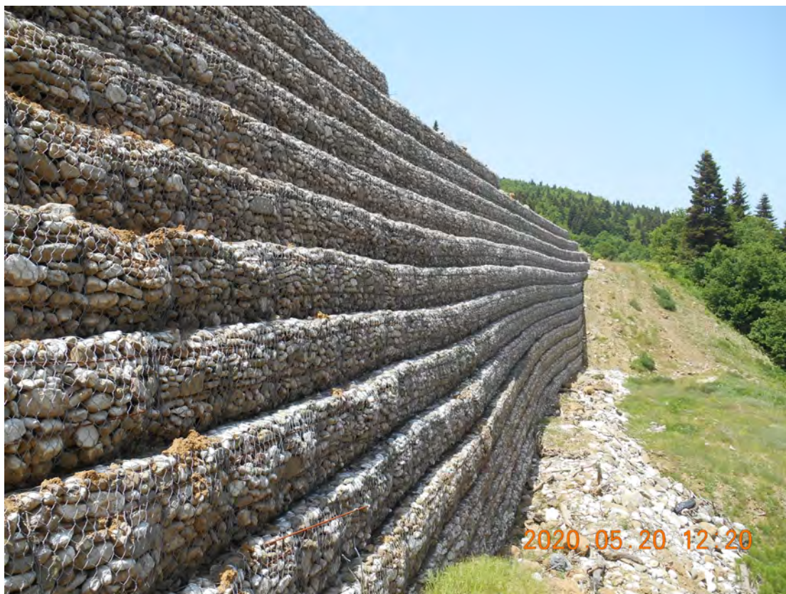
Φωτ. 21: Άποψη οπλισμένου επιχώματος, με μικρές παραμορφώσεις.
