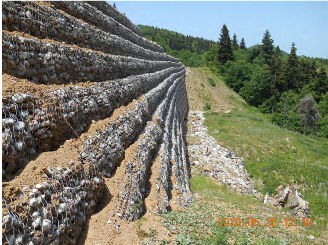
Φωτ. 19: Άποψη οπλισμένου επιχώματος, με μικρές παραμορφώσεις.
