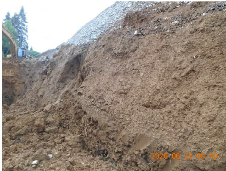
Φωτ. 18: Δάπεδο εκσκαφής φρέατος Φ2, όπου φαίνεται η θεμελίωση των συρματοκιβωτίων επί των πλευρικών κορημάτων, στα πλαίσια της Γεωτεχνικής Έρευνας - Μελέτης αποκατάστασης αστοχίας δύο επιχωμάτων στη Χ.Θ. 2+030 & 2+800 στο έργο: Παράκαμψη Νεοχωρίου.
