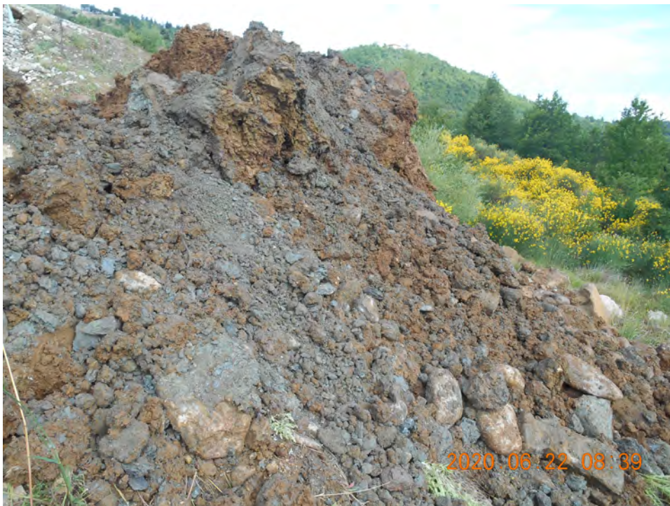
Φωτ. 12: Υλικά εκσκαφής του Φρέατος Φ1, στα πλαίσια της Γεωτεχνικής Έρευνας - Μελέτης αποκατάστασης αστοχίας δύο επιχωμάτων στη Χ.Θ. 2+030 & 2+800 στο έργο: Παράκαμψη Νεοχωρίου.
