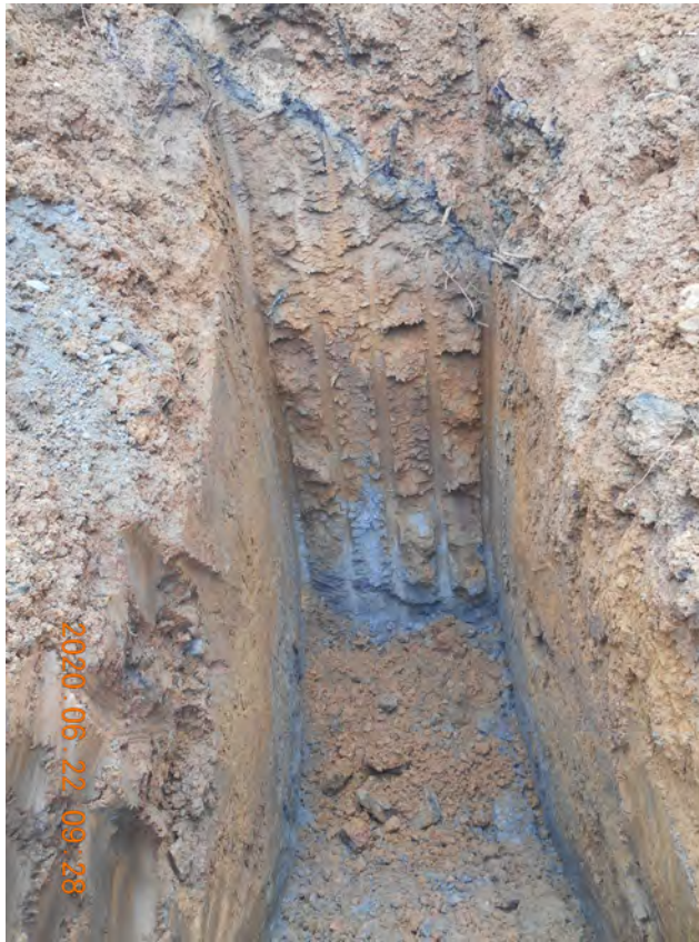
Φωτ. 17: Παρειά εκσκαφής φρέατος Φ2, στα πλαίσια της Γεωτεχνικής Έρευνας - Μελέτης αποκατάστασης αστοχίας δύο επιχωμάτων στη Χ.Θ. 2+030 & 2+800 στο έργο: Παράκαμψη Νεοχωρίου, όπου φαίνεται η επαφή με τον πηλίτη
