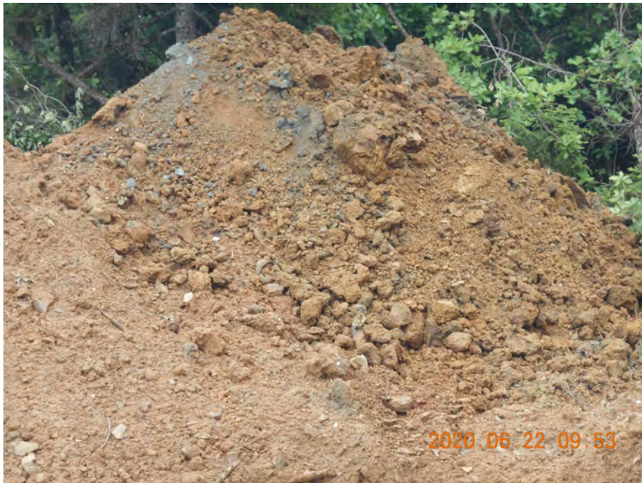
Φωτ. 16: Υλικά εκσκαφής του Φρέατος Φ2, στα πλαίσια της Γεωτεχνικής Έρευνας - Μελέτης αποκατάστασης αστοχίας δύο επιχωμάτων στη Χ.Θ. 2+030 & 2+800 στο έργο: Παράκαμψη Νεοχωρίου.
