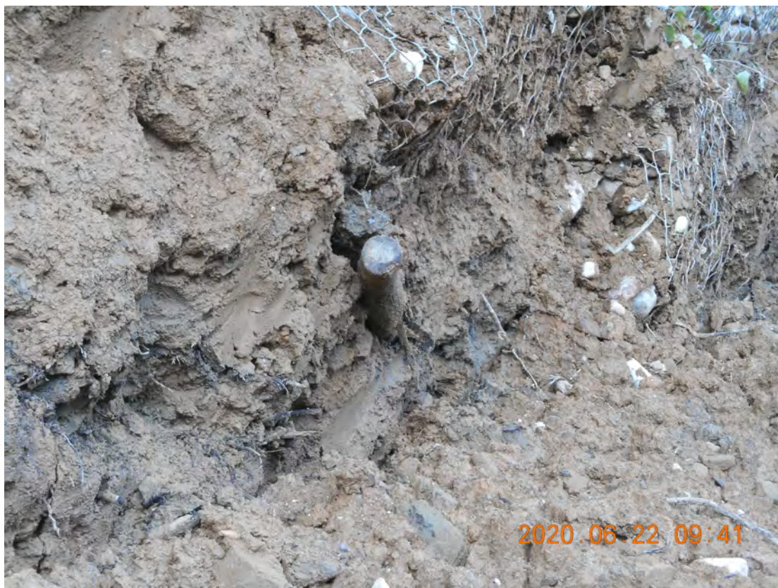
Φωτ. 27: Άποψη οπλισμένου επιχώματος, με θεμελίωση χωρίς εξυγίανση.
