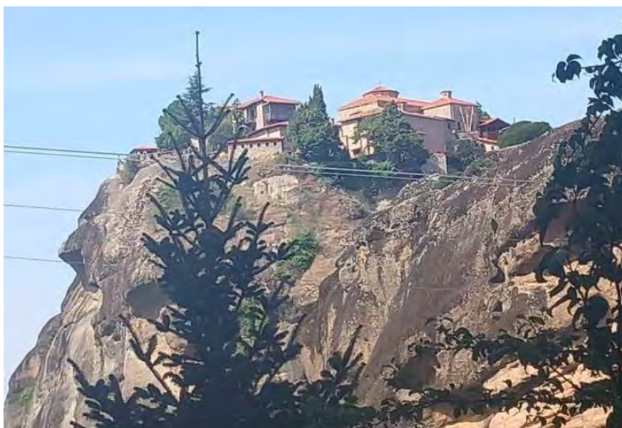
Εικ. 26 Τα σύρματα όπου κινείται το αναβατόριο, ο σύγχρονος τρόπος μεταφοράς ατόμων και αντικειμένων.
