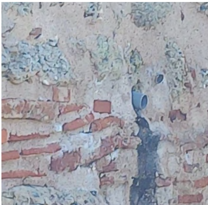
Εικ. 31 Μια από τις εργασίες συντήρησης και επέμβασης για να είναι το κτίριο λειτουργικό είναι και η τοποθέτηση πλαστικού αγωγού.
