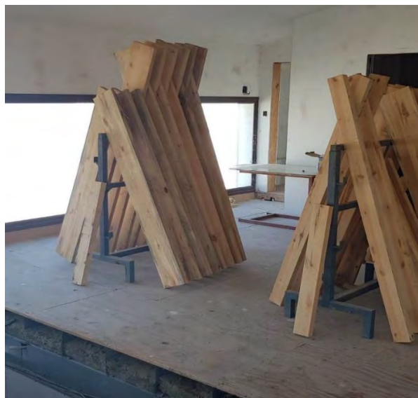
Εικ. 40 Στοίβαξη ξυλείας για φυσική ξήρανση
