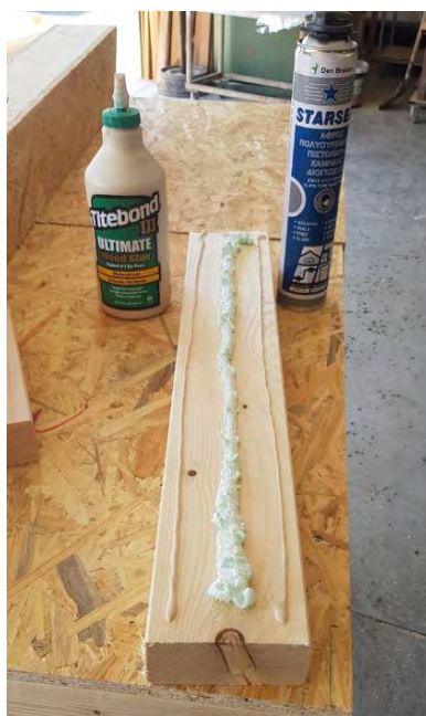
Εικ. 52 Εφαρμογή κλειδιών με αφρό πολυουρεθάνης και κόλλα
