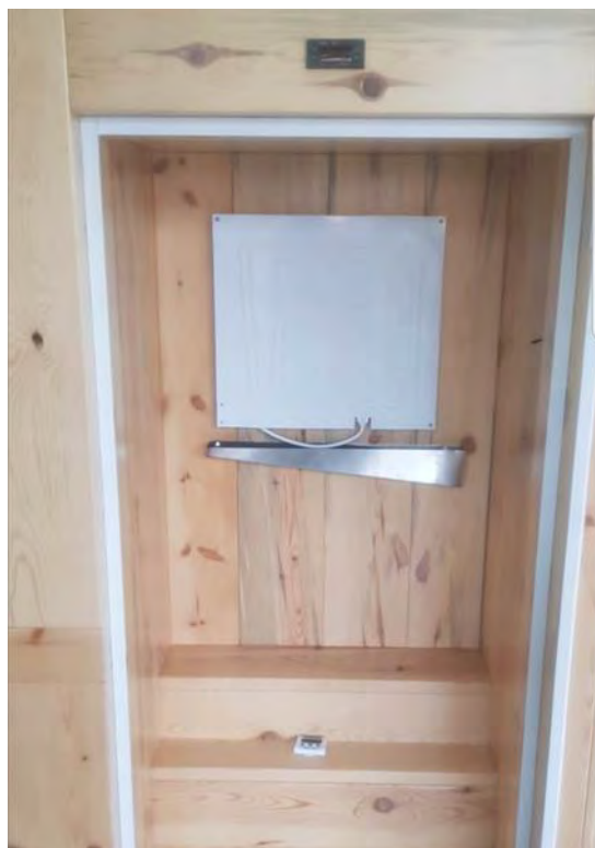
Εικ. 92 Εφαρμογή evaporator, θερμοστάτη και συλλέκτη νερού
