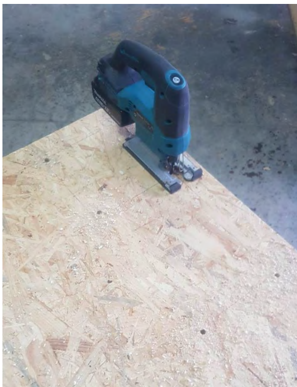
Εικ. 63 Άνοιγμα οπών για την εφαρμογή των τροχών
