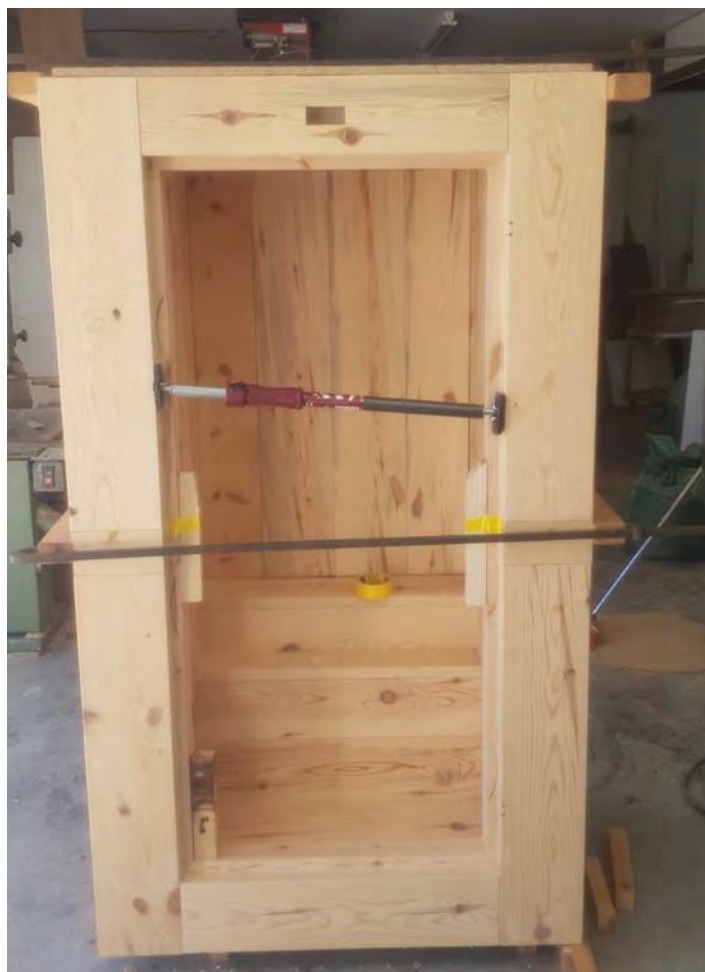
Εικ. 88 Εφαρμογή όλων των τεμαχίων εξωτερικά και εσωτερικά της κατασκευής
