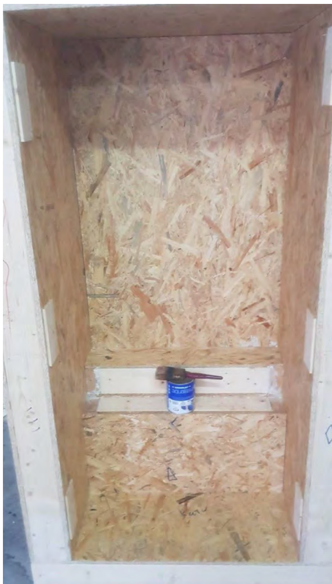
Εικ. 83 Επικάλυψη εσωτερικού χώρου κάβας
