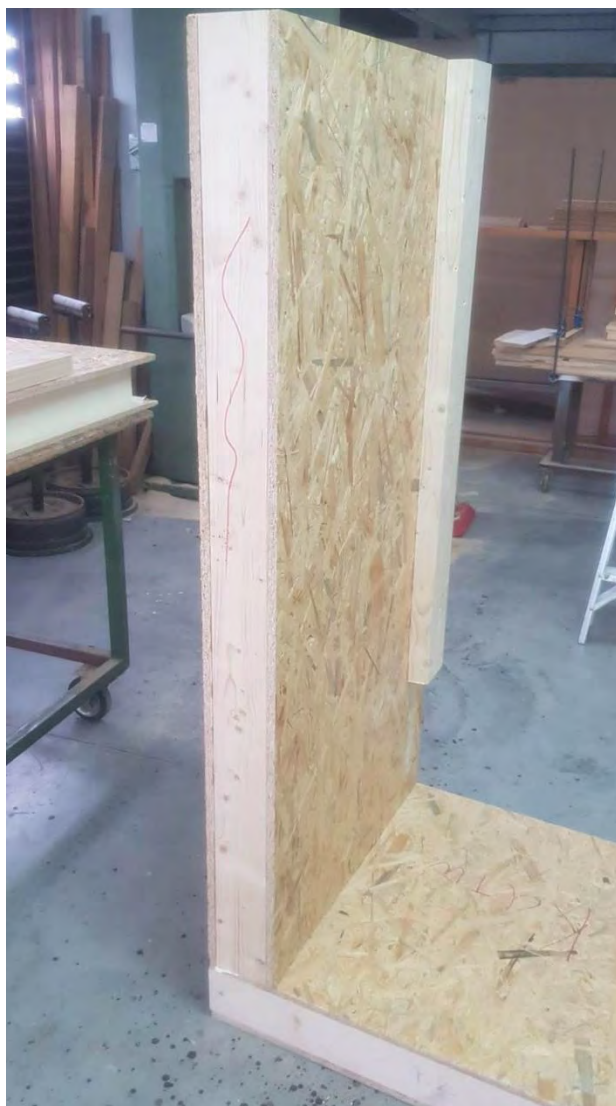
Εικ. 65 Τοποθέτηση αριστερού τοιχώματος
