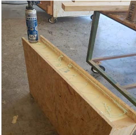
Εικ. 49 Εφαρμογή αφρού πολυουρεθάνης για συγκόλληση και σφράγιση
