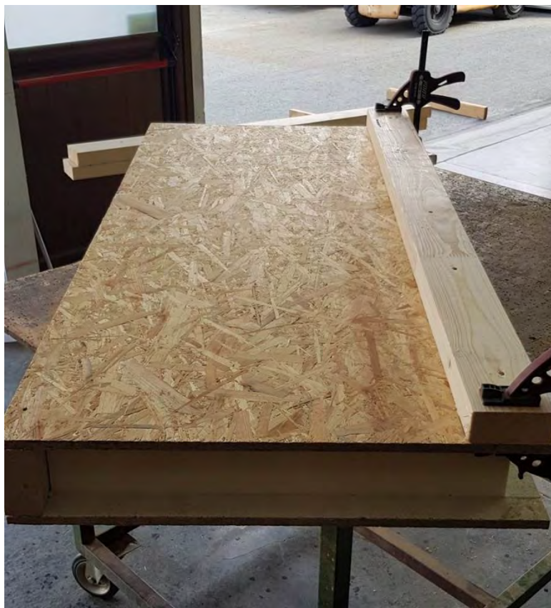
Εικ. 56 Εφαρμογή ξυλόβιδων με τη βοήθεια σφικτήρων
