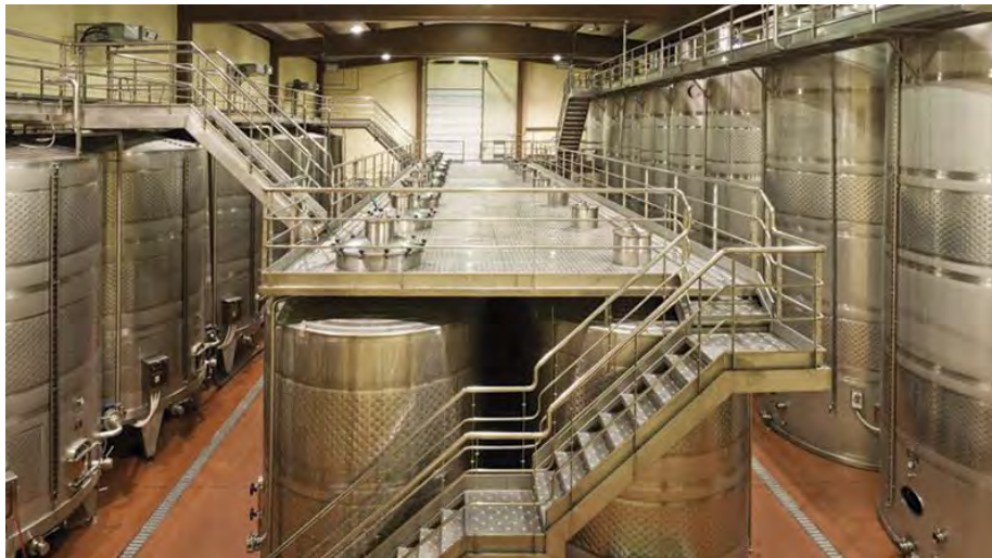
Εικ. 9 Χώρος δεξαμενών κρασιού
