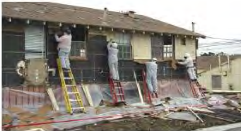
Εικόνα 12: Διαχωρισμός ξύλινων μελών κατοικιών -προ κατεδάφισης τους με σκοπό την επαναχρησιμοποίηση
