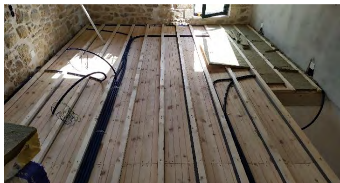
Εικόνα 8 Καδρόνια 5x5 σε υποδομή πατώματος
