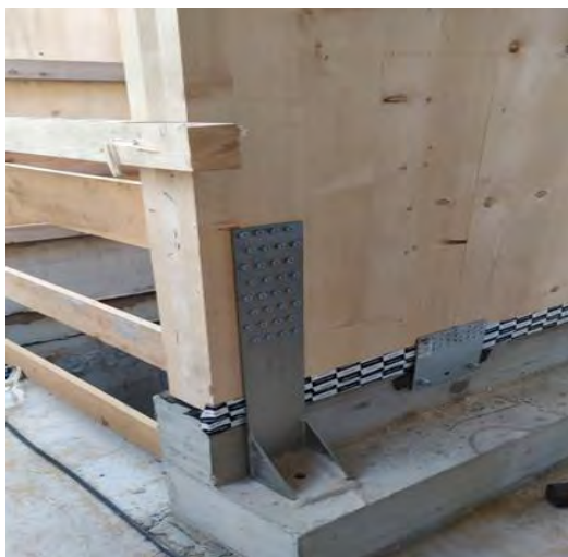
Εικόνα 62 Γωνιακοί βραχίονες για την σύνδεση θεμελίωσης - τοίχου
