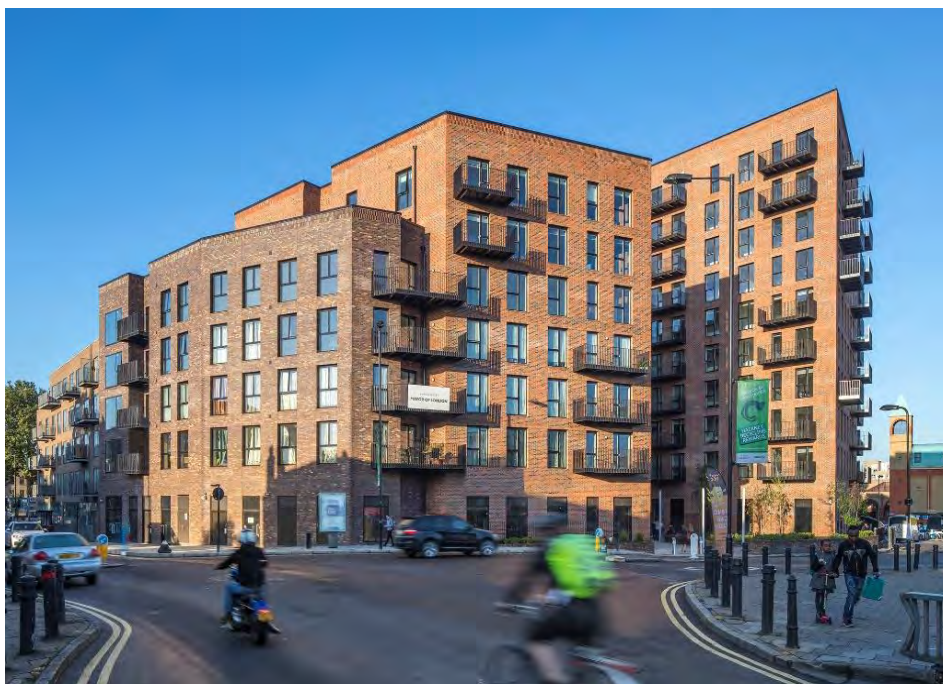
Εικόνα 29 Κτίριο από CLT
