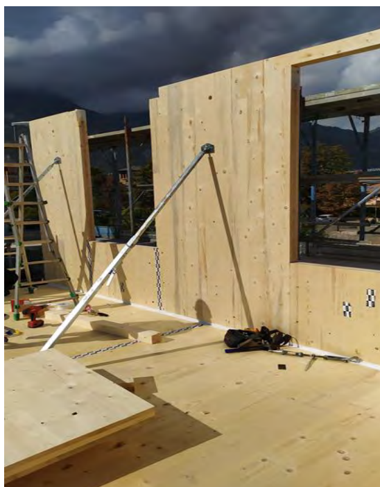
Εικόνα 36 Πάνελ CLT με διαμορφωμένα τα ανοίγματα στο χώρο του εργοταξίου
