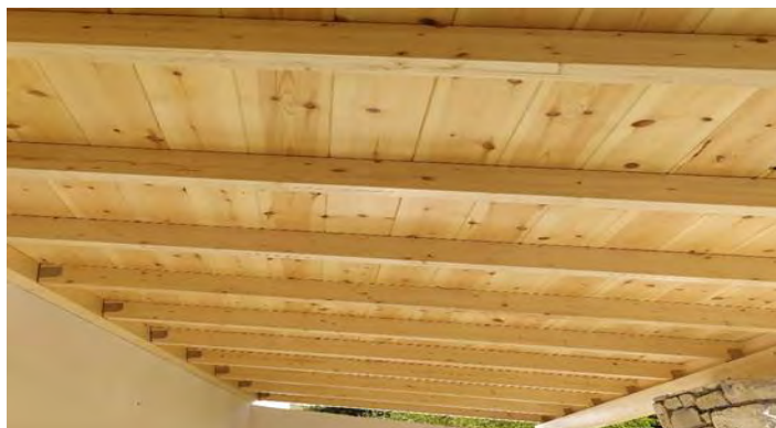
Εικόνα 6 Τάβλες σε επικάλυψη στέγης
