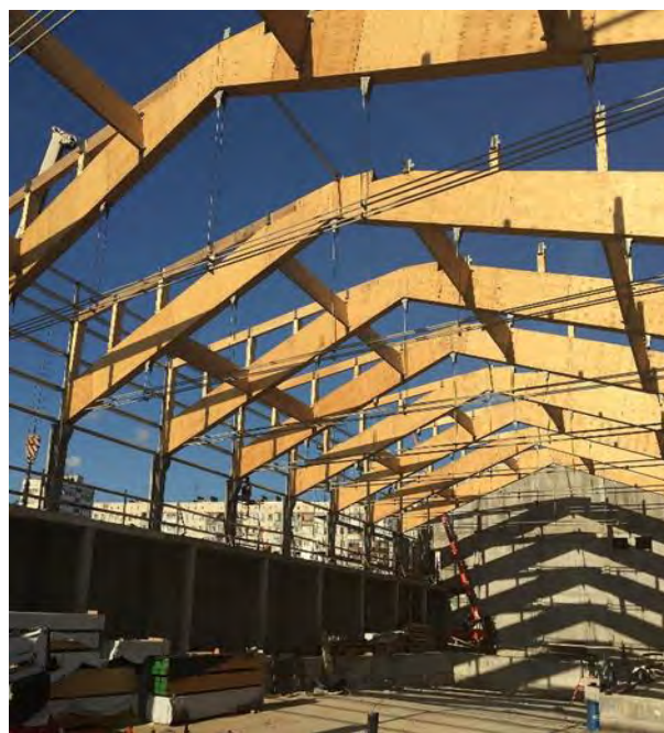
Εικόνα 21 Βιομηχανικό κτίριο από LVL
