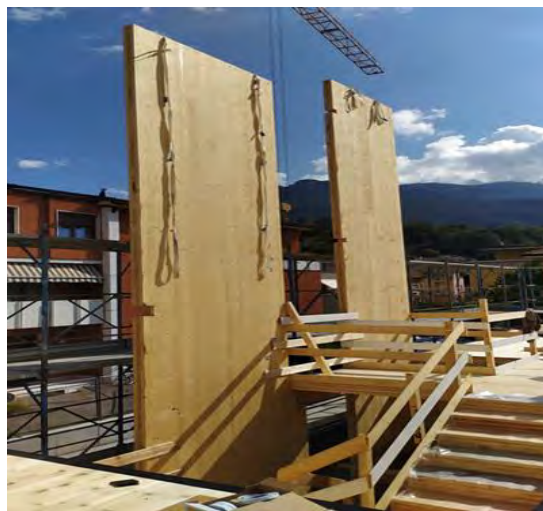
Εικόνα 63 Ιμάντες μεταφοράς πάνελ στο εργοτάξιο
