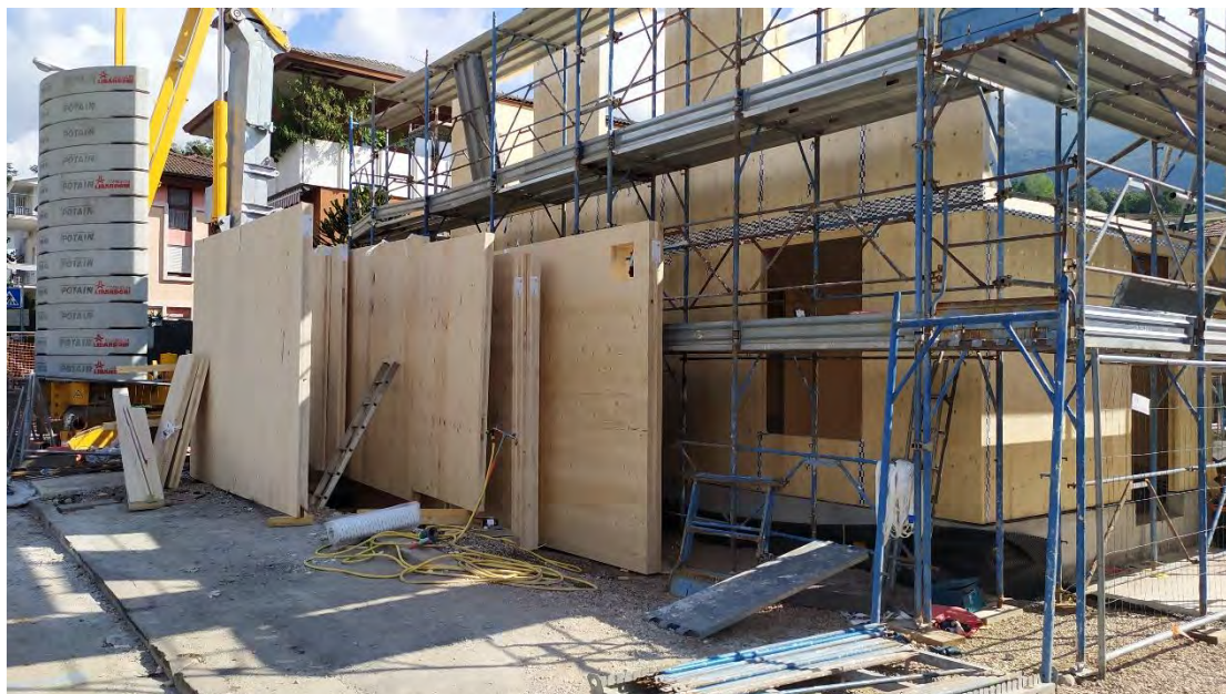
Εικόνα 38 Εργοτάξιο – κατασκευή κτιρίου από ξυλεία CLT
