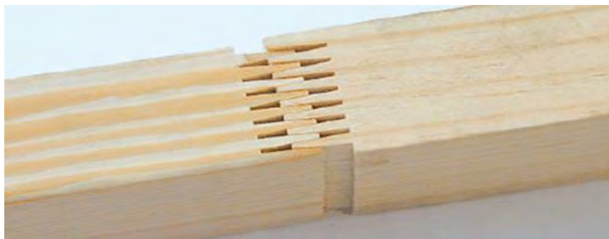
Εικόνα 33 Δακτυλοειδής σύνδεση (finger-joint)
