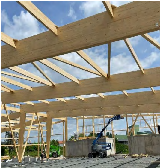
Εικόνα 18 Κατασκευή βιομηχανικού κτιρίου από επικολλητή ξυλεία
