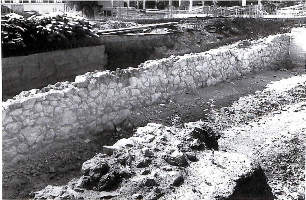
Εικόνα 82. Δημοτικό Σχολείο –Οδός Αττιδος (34). Αναλημματικοί τοίχοι με αντιπλημμυρική χρήση. (Lohmann 1992, εικ. 50).
