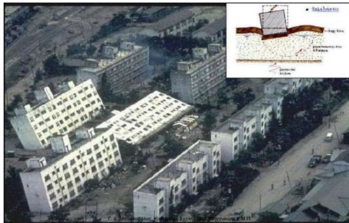
Εικόνα 6: Αστοχία λόγω ρευστοποίησης εδάφους - Niigata, Ιαπωνία (1964)
