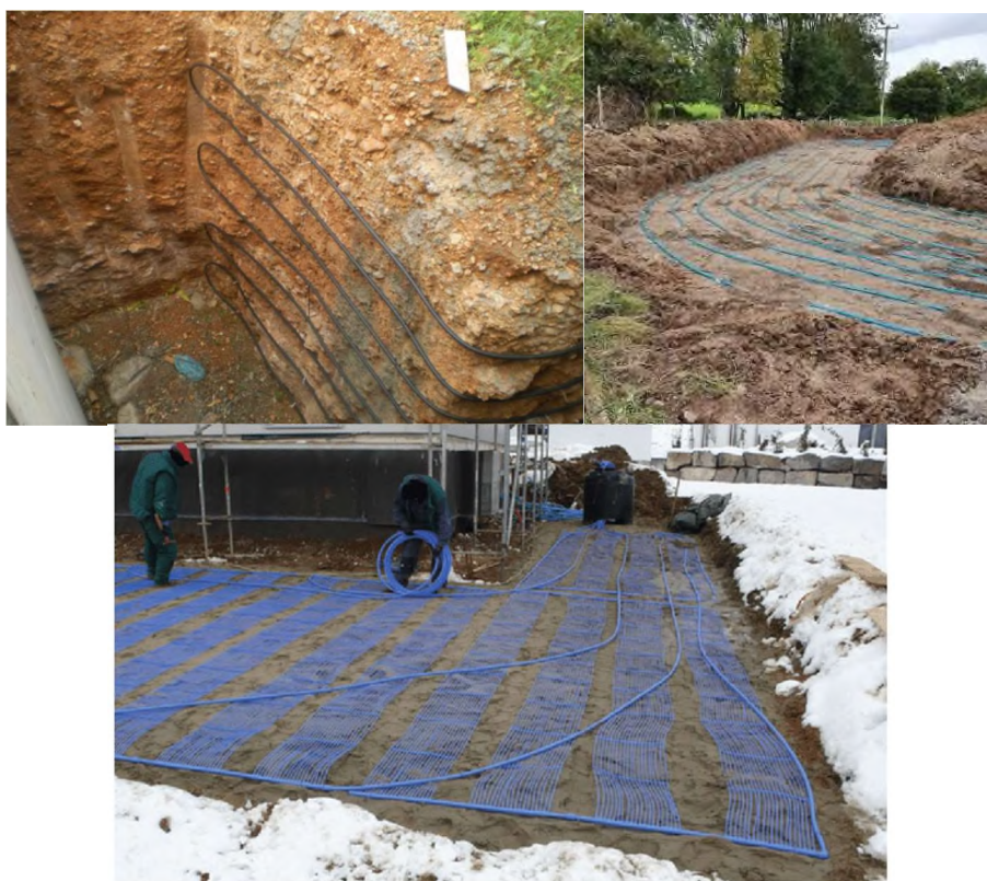
Σχήμα 2.21: Διατάξεις οριζόντιων βρόχων [5,43,44]
