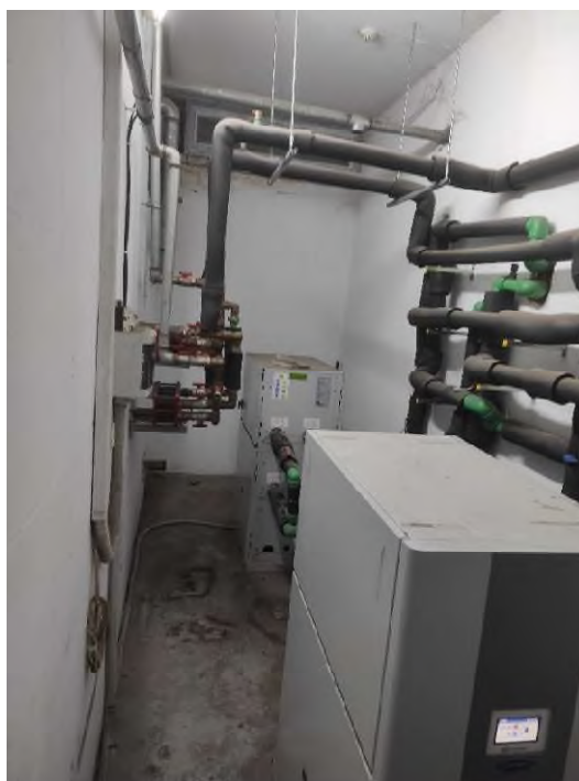
Σχήμα 6.5: Διάταξη “master-slave” 2 όμοιων Γ.Α.Θ. της εγκατάστασης M4
