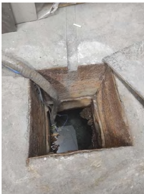
Σχήμα 6.4: Γεώτρηση παραγωγής της εγκατάστασης M4
