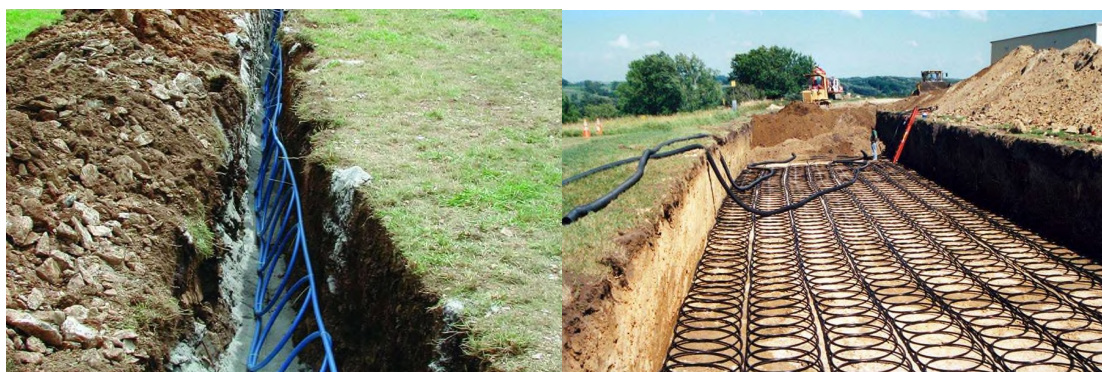
Σχήμα 2.22: Οριζόντιοι σπειροειδείς βρόχοι τύπου “slinky” [46,47]
