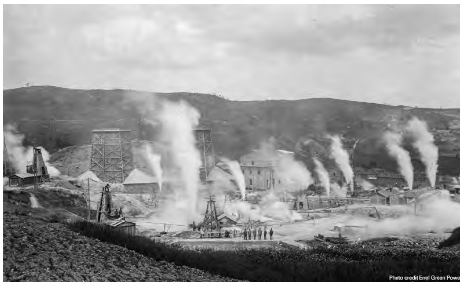
Σχήμα 2.14: Εργοστάσιο ξηρού ατμού στην Τοσκάνη (1904) [32]
