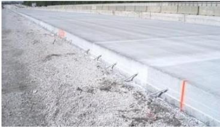
Εικόνα 4. . Παράδειγμα κατασκευής οδοστρώματος σκυροδέματος (Πηγή: https://cementconcrete.org/structural/cement-concrete-road-pavement/2780 ).
