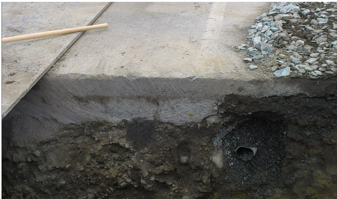
Εικόνα 5.. Παράδειγμα σύνθετου οδοστρώματος (πηγή:
