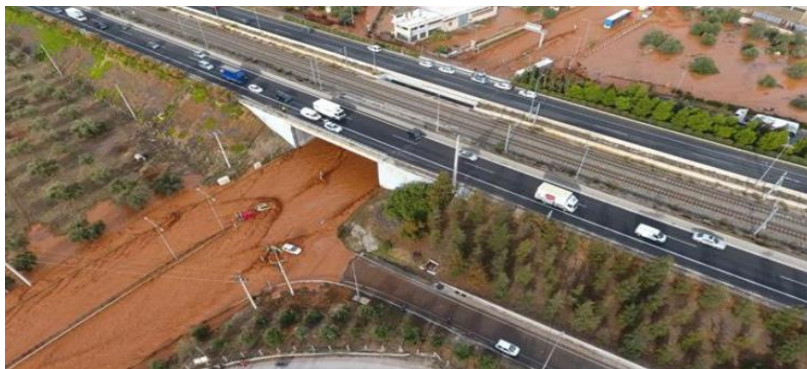
Εικόνα 4 ο : Εδώ παρατηρούμε την διέλευση του κύματος κάτω από την γέφυρα της Αττικής Οδού (Μαυρογεώργος, Κ. 2020).
