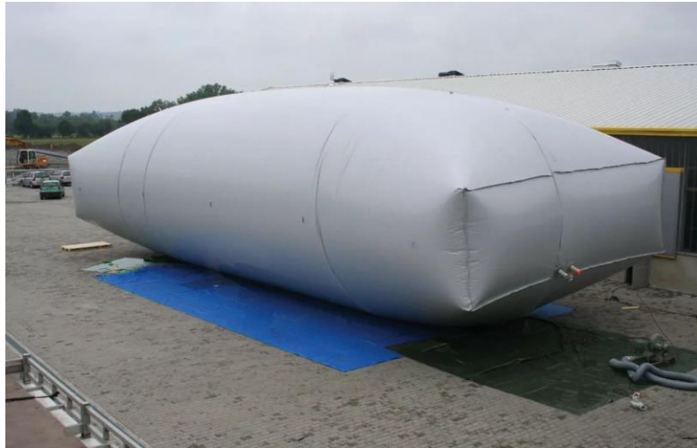
Εικόνα 31:Εξωτερικές δεξαμενές αποθήκευσης αερίου χαμηλής πίεσης (60)
