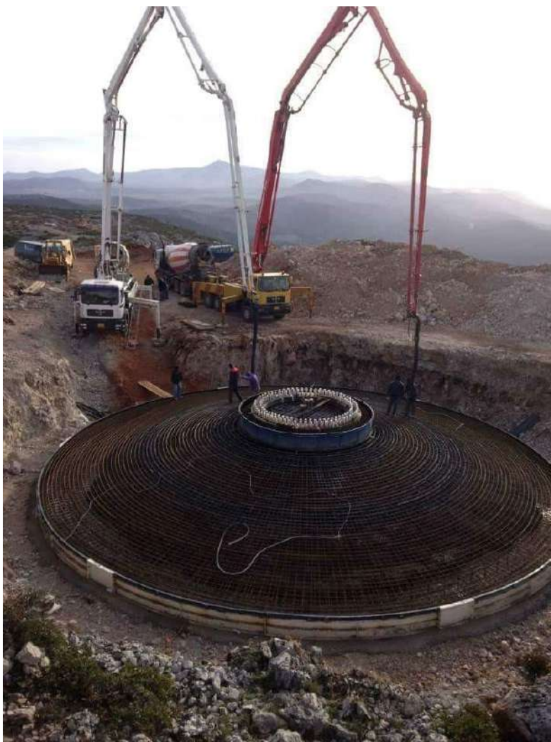
Εικόνα 10: Θεμέλια ανεμογεννήτριας
