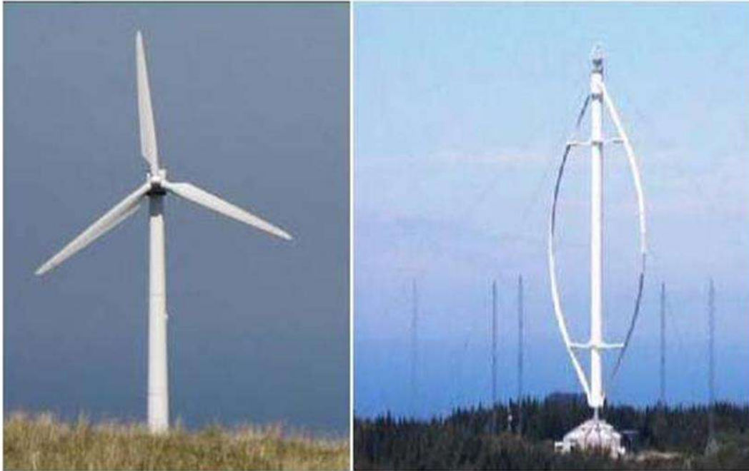
Εικόνα 3 : ανεμογεννήτριες οριζόντιου άξονα (αριστερά) και καθέτου άξονα (δεξιά) (Global-Energy.EU 2012)
