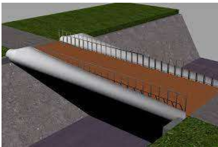
Εικόνα 21: Γέφυρα κατασκευασμένη από πτερύγιο (Queen's University Belfast 2023)
