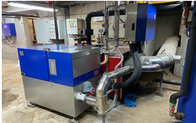
Εικόνα 3.1 Σύστημα συμπαραγωγής στη βιομηχανία
