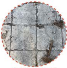
πλακάστρωτο τύπος 2 εξωτερικός χώρος
