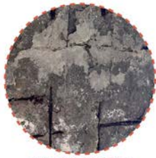
οπλισμένο ακυρόδεμα σκελετός κτηρίου
