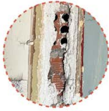
τοιχοποιία με τούβλο σκελετός κτηρίου
