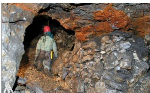
(iii) Κατολίσθηση Μεταλλείου
