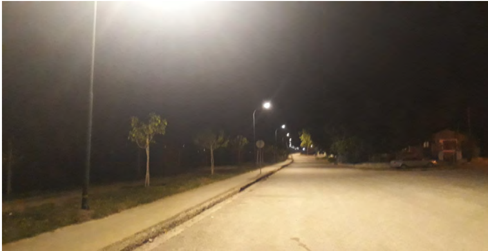
Εικόνα 34. Νέος χαμηλός φωτισμός LED στις όχθες του Ληθαίου. Νυχτερινή λήψη. (φωτ. αρχείο Ν. Γιαννούλα)
