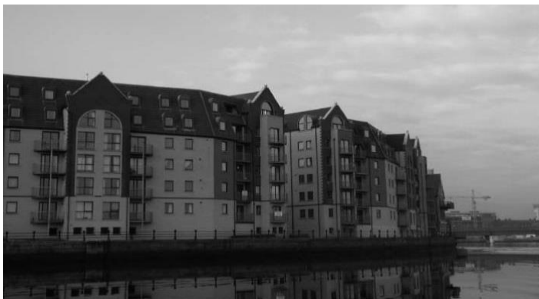
Εικόνα 30: Μπέλφαστ: νέα διαμερίσματα στο Laganside Πηγή: McKay, S. (2003). Urban Regeneration in Belfast. Urban regeneration in Europe.
