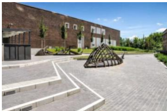
Εικόνα 86: Επίστρωση με κυβόλιθο
