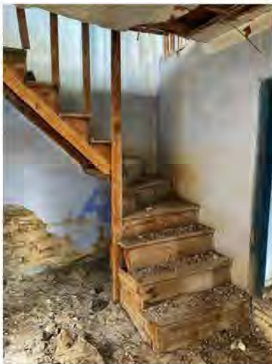
Εικόνα 9: Η σκάλα ενός διώροφου σπιτιού. Α.ΓΙΟΥΒΡΗ, 2023
