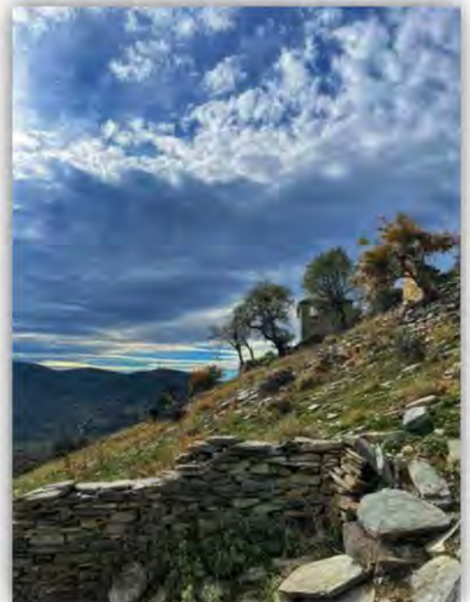
Εικόνα 6: Ένας μισό-γκρεμισμένος τοίχος σπιτιού. Α.ΓΙΟΥΒΡΗ, 2023.
